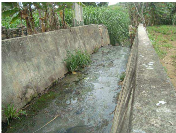
Fotografia 5. Canal de esgotos domésticos no município de Boqueirão
