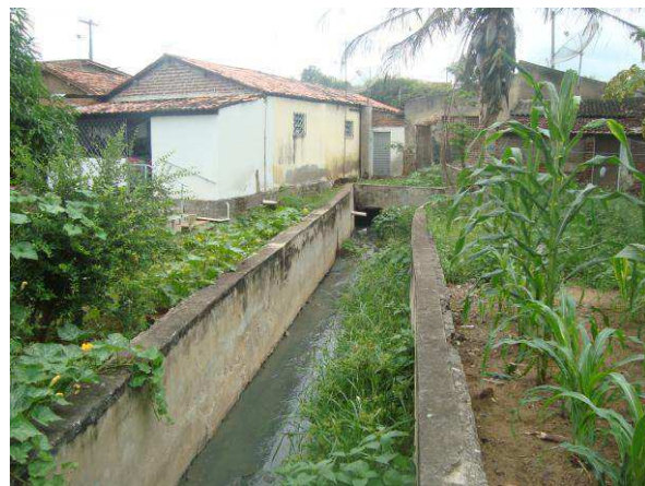
Fotografia 2. Canal de esgotos domésticos no município de Boqueirão
