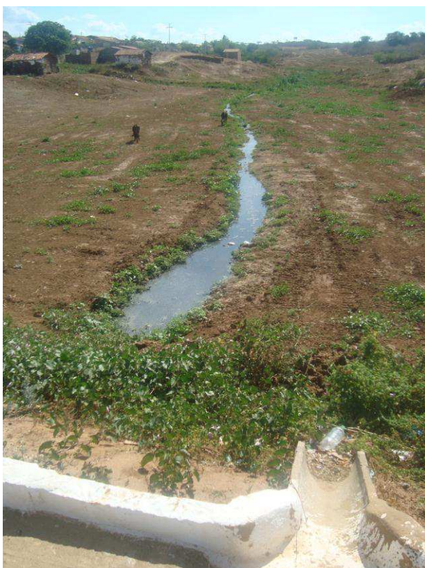
Fotografia 51. Esgotos do município de Caraúbas com áreas degradadas
