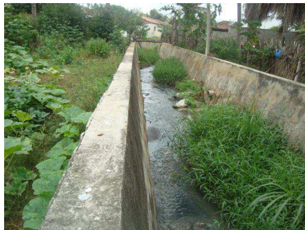
Fotografia 4. Canal de esgotos domésticos no município de Boqueirão
