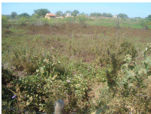
Fotografia 80. Lagoa de esgotos no município de Sumé
