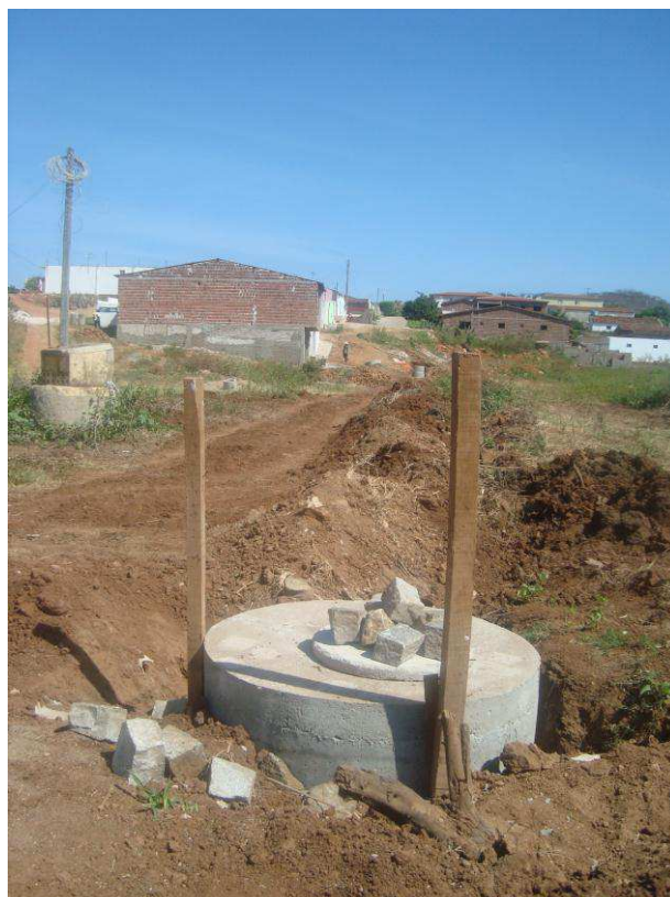
Fotografia 78. Obra de esgotamento sanitários no município de Sumé
