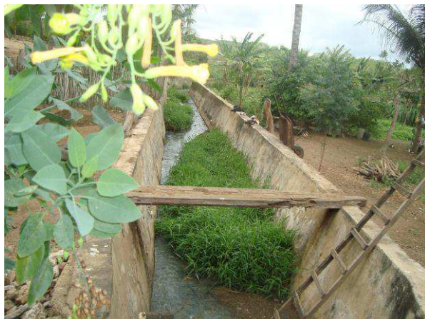
Fotografia 3. Canal de esgotos domésticos no município de Boqueirão
