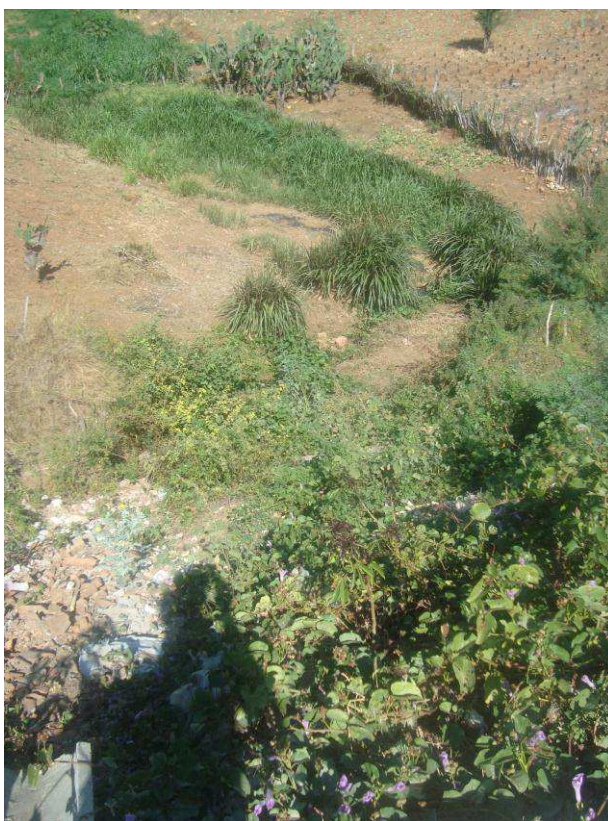
Fotografia 52. Esgotos do município de Caraúbas com áreas degradadas
