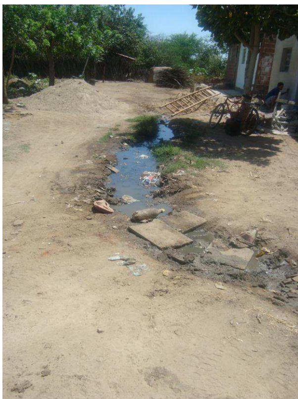
Fotografia 95. Esgoto doméstico a céu aberto no município de Prata
