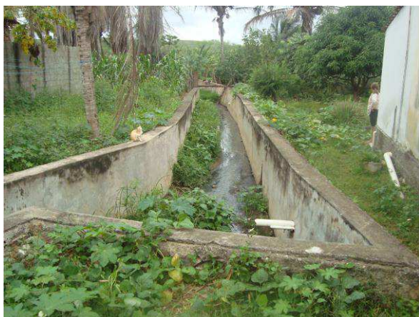
Fotografia 1. Canal de esgotos domésticos no município de Boqueirão
