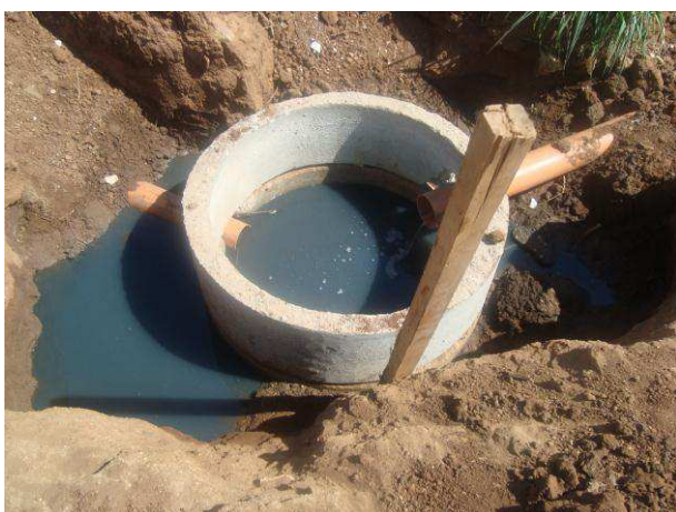
Fotografia 79. Obra de esgotamento sanitários no município de Sumé
