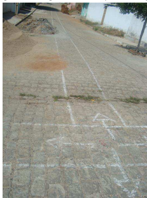
Fotografia 76. Obra de esgotamento sanitários no município de Sumé
