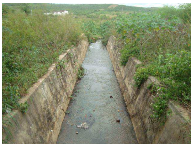
Fotografia 9. Canal de esgotos domésticos no município de Boqueirão
