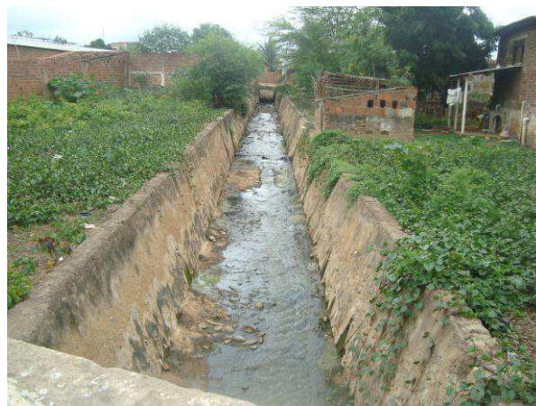
Fotografia 8. Canal de esgotos domésticos no município de Boqueirão
