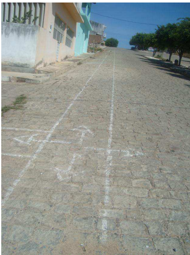
Fotografia 77. Obra de esgotamento sanitários no município de Sumé
