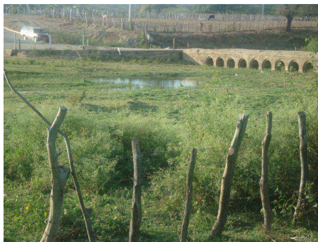
Fotografia 72. Esgoto no município do Congo
