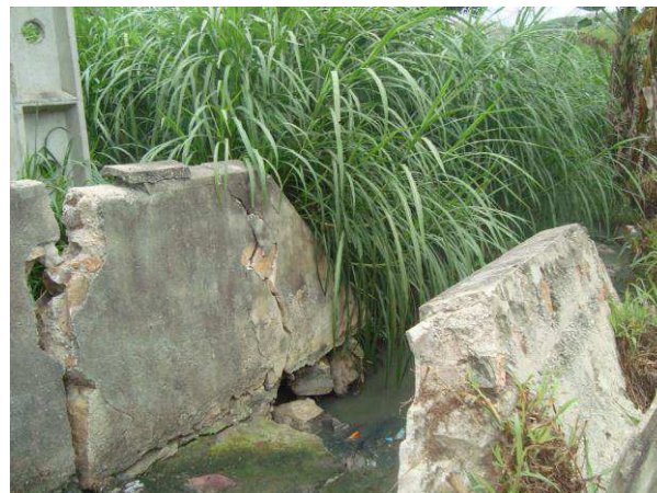
Fotografia 6. Canal de esgotos domésticos no município de Boqueirão
