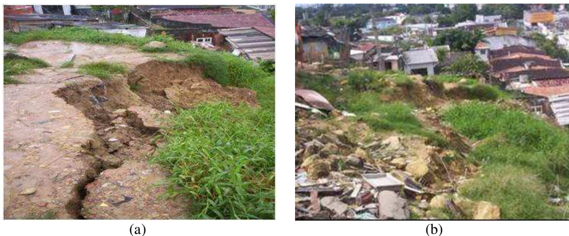
Figura 15 - Ilustração do deslizamento e surgimento da fenda (a) e escombros da demolição das habitações (b) no bairro de Água Fria. Fonte: CODECIR
