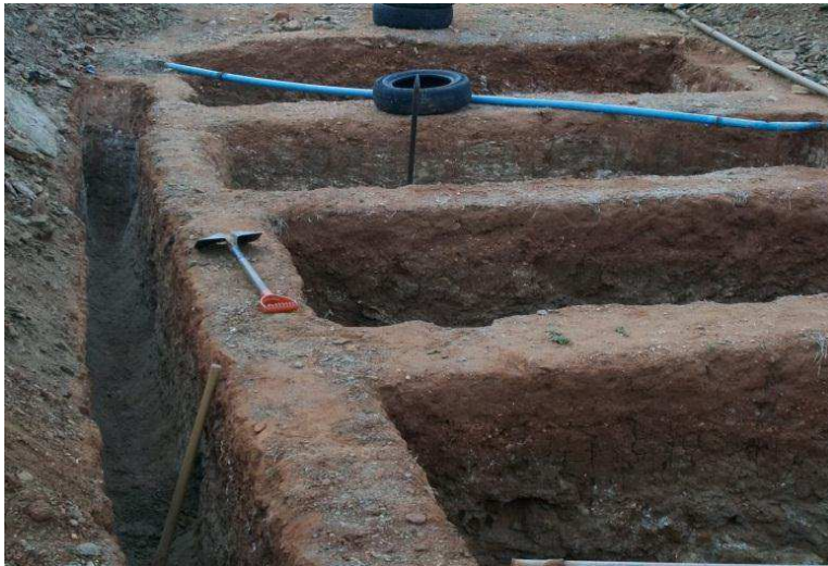
Figura 7 - Escavação das unidades.
