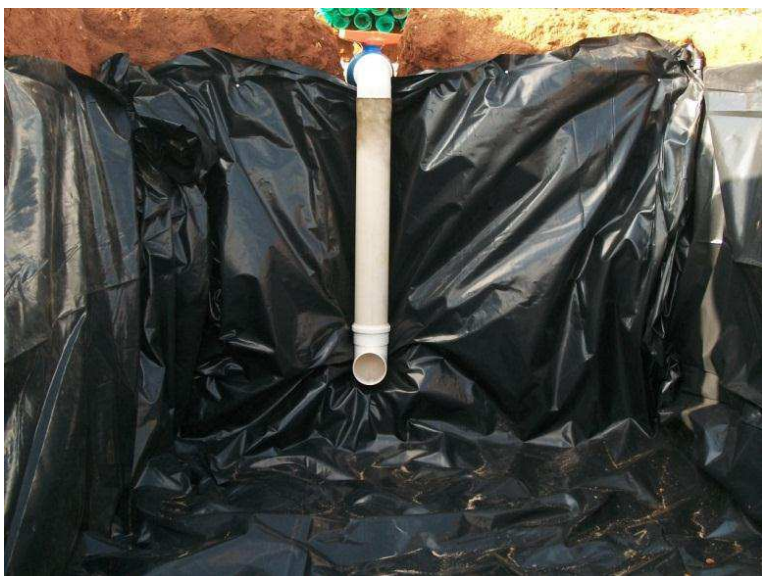
Figura 8 - Impermeabilização das unidades.
