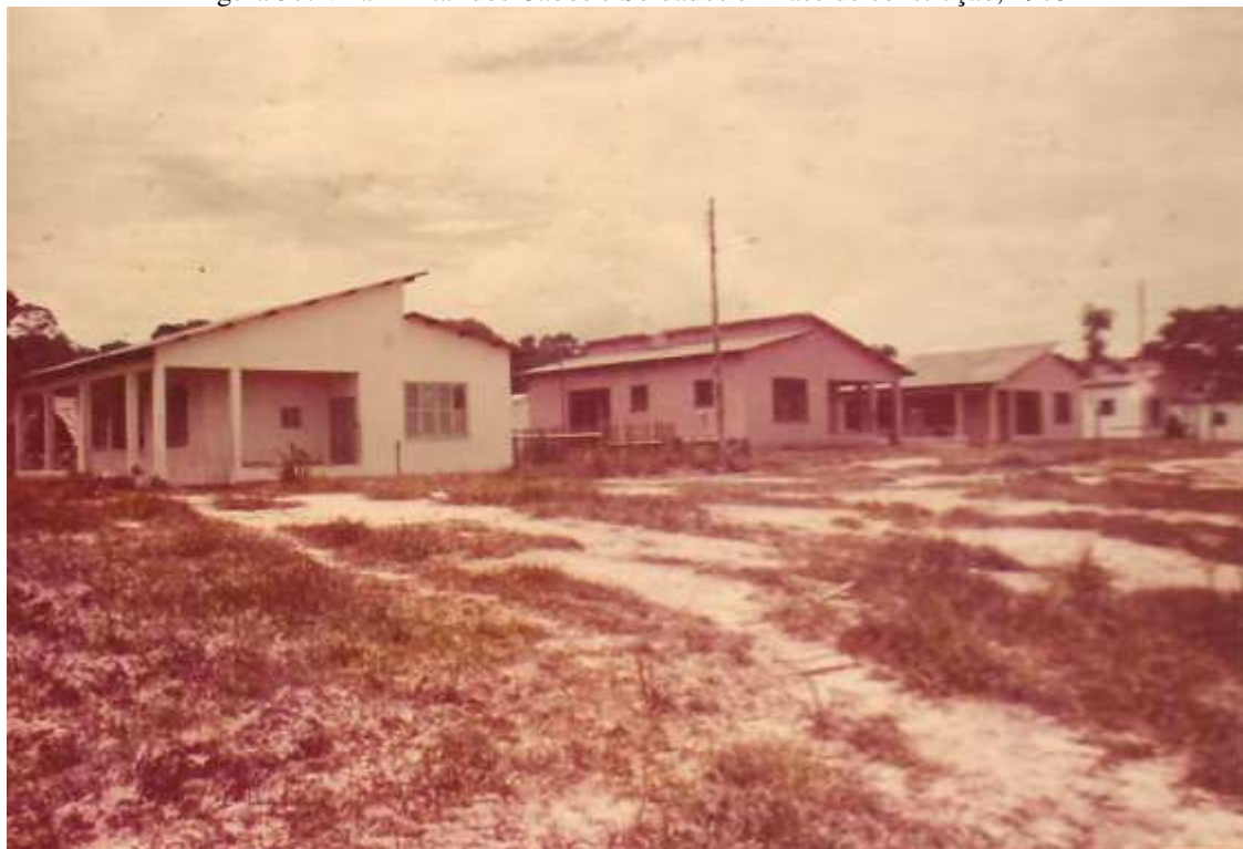
Figura 37: Vila Militar dos Cabos e Soldados em fase de construção, 1975
