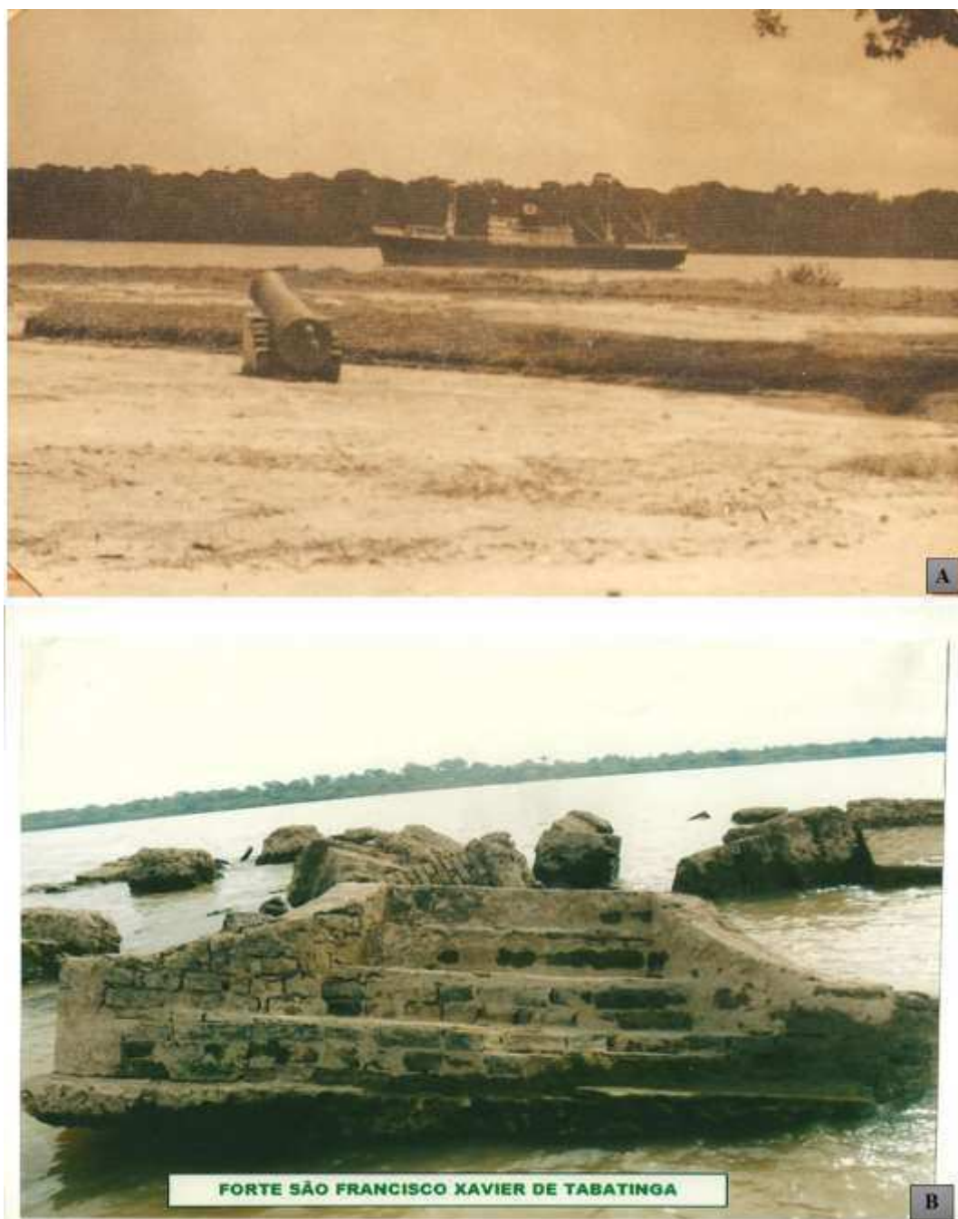
Figura 28: Estruturas do Forte São Francisco Xavier de Tabatinga
