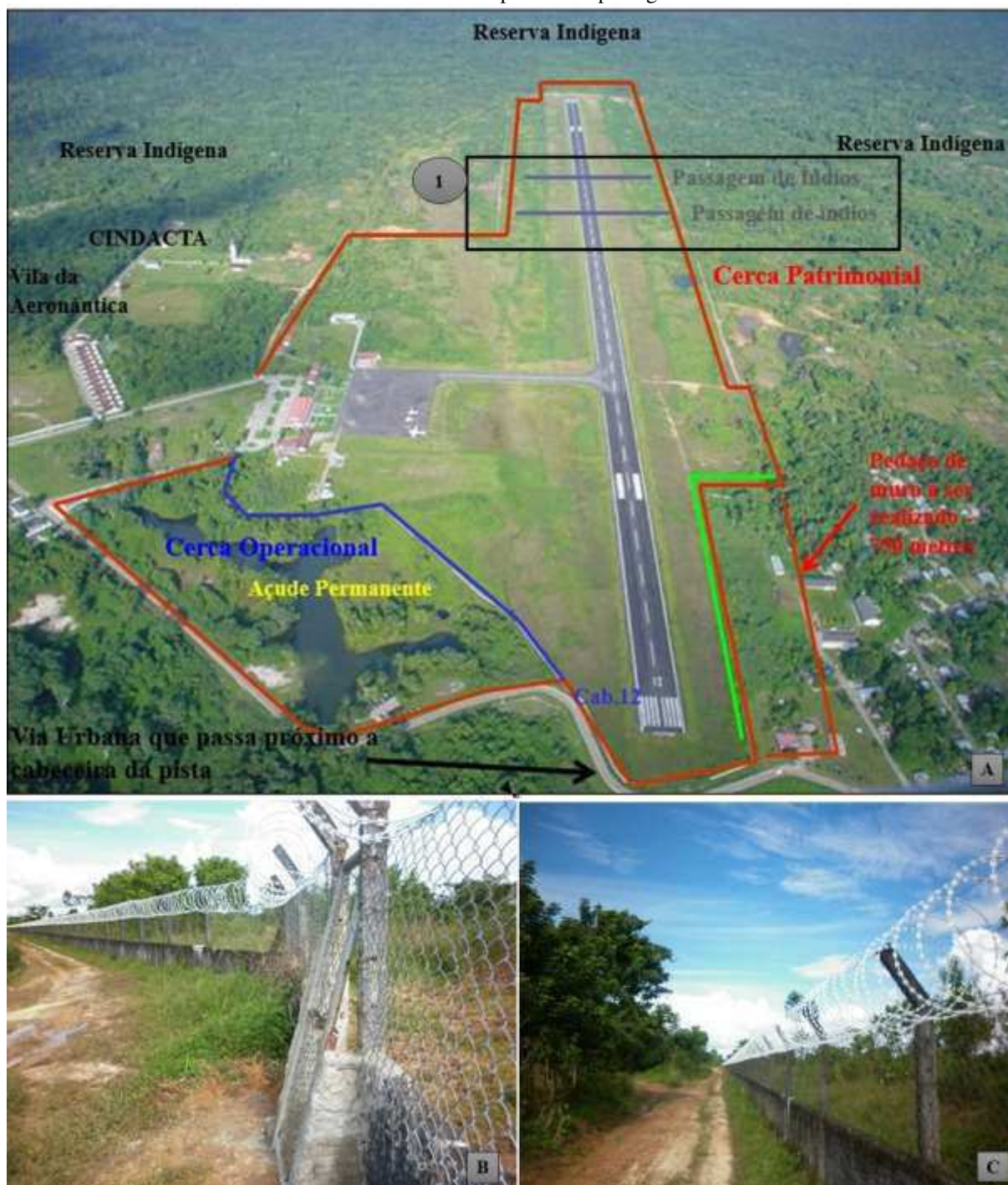
Figura 32: A - Delimitação das áreas de passagens dos Tikuna pela pista de pouso. B - Portão de passagem. C - Percurso entre os portões de passagem
