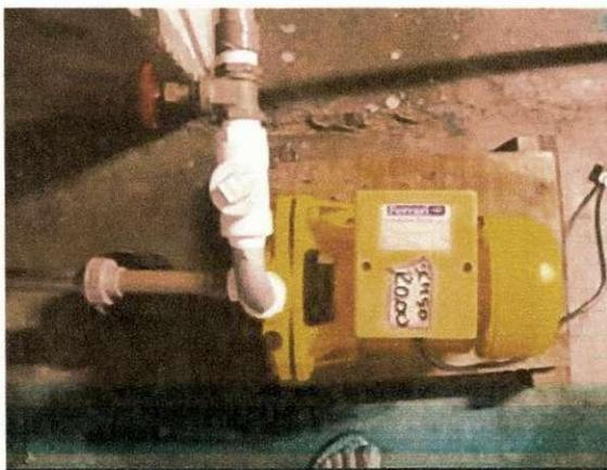
Figura 05- Eletrobomba monobloco Ferrari utilizada para pressão elevada.
