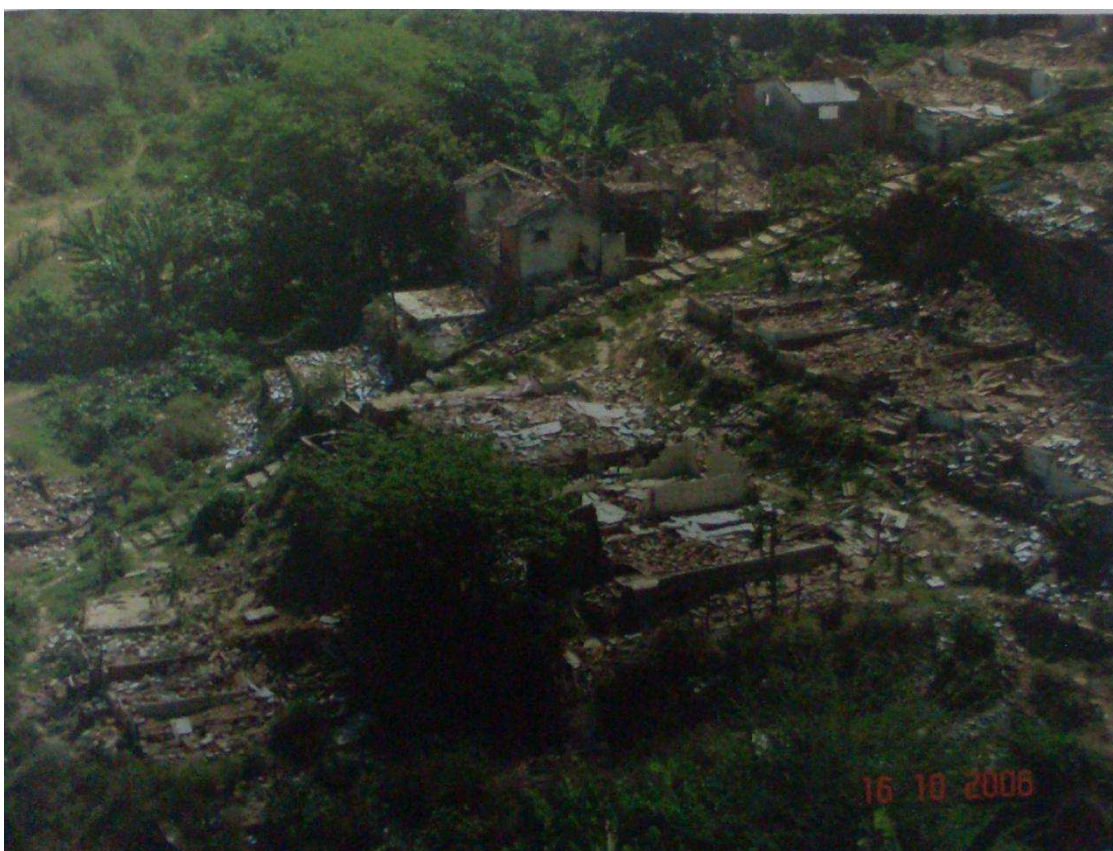
Vista parcial da Favela da Cachoeira com parte das casas demolidas após a remoção das famílias. Fotografia do acervo da Cehap.
