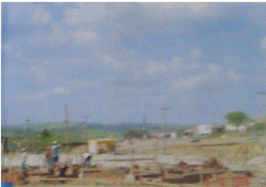
Canteiro de obras do loteamento Glória. Fotografia do acervo da Cehap.
