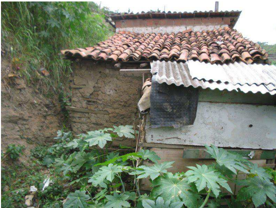
Figura 6. Fotografia representando o banheiro construído por alguns moradores. Em geral, eram feitos fora da casa, numa espécie de anexo. Os materiais que utilizavam na construção eram diversos: barro, madeira, plástico, lata, lonas, papelão, telhas. Fotografia do acervo pessoal de José Martins.
