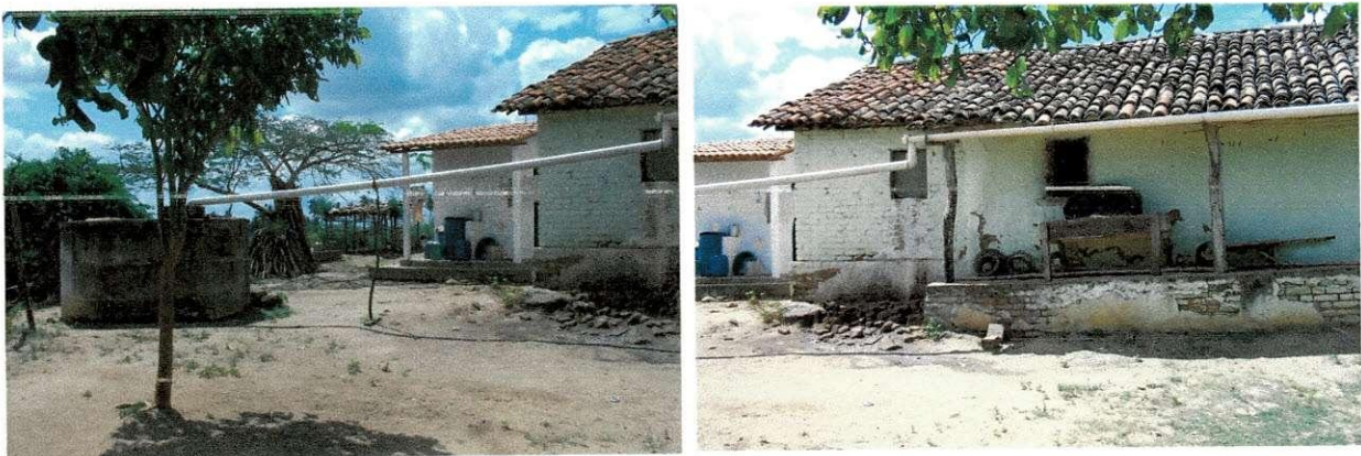
Figura 08. Telhado com calha e cisterna para a captação de água de chuva, agosto de 2007.
