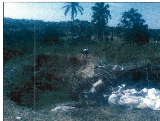
Figura 8. Profundidade da voçoroca
