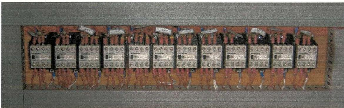
**Figura 10 – Contatores de Comando das Cargas**
