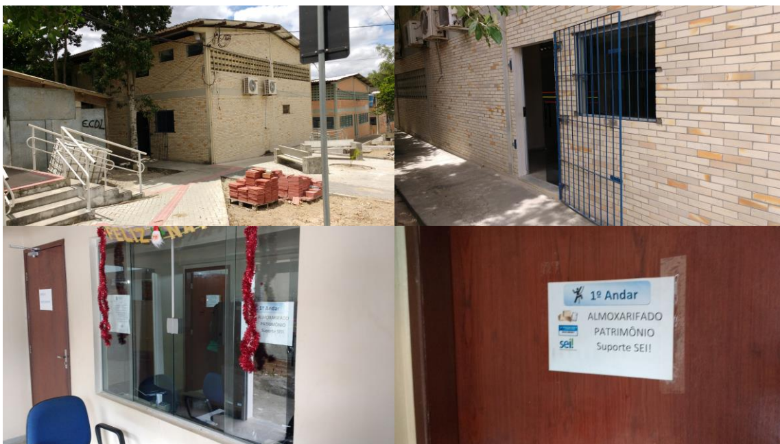
Figura 6 – Quadro com imagens do setor de patrimônio do câmpus de Campina Grande
