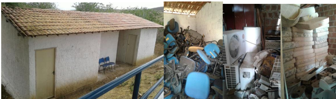
Figura 22 – Quadro com imagens de bens em depósito no CES
