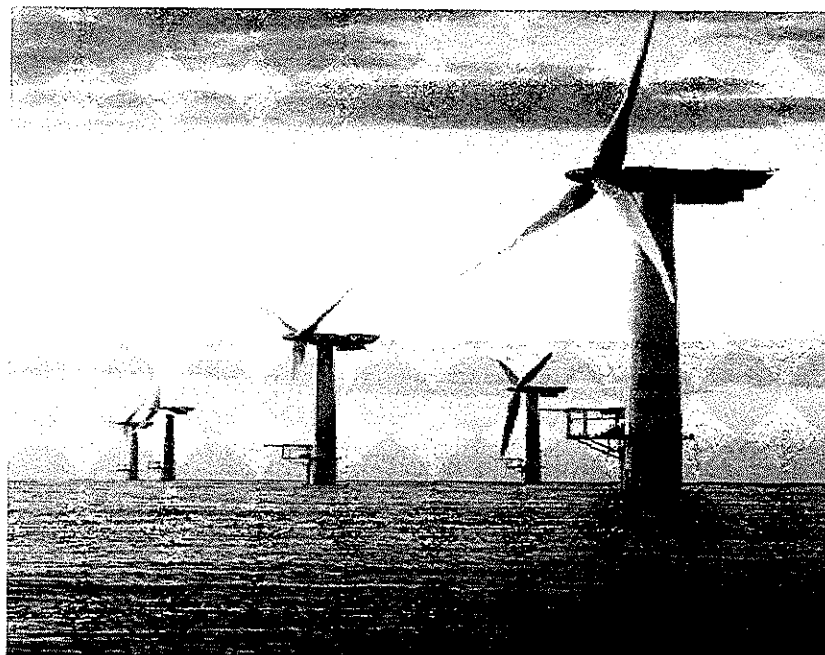
Figura 4.17 – Fazenda eólica offshore (Dinamarca) Fonte: DWIA, 2002
