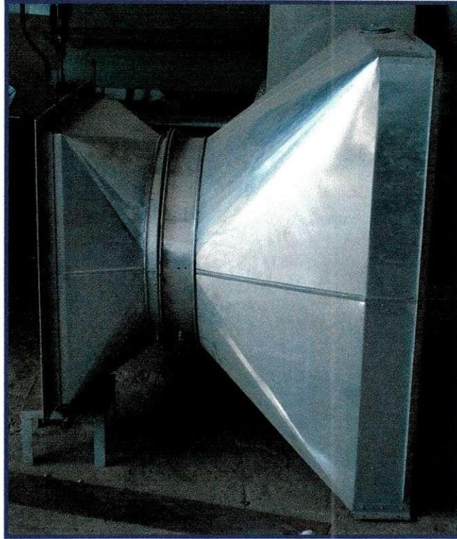
**Figura 6.4 – Carcaça completa do Resfriador Evaporativo**
