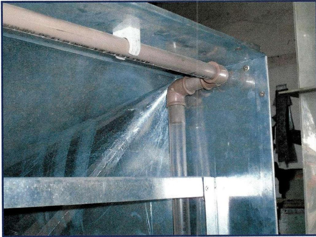
**Figura 6.9 – Detalhe de conexão e fixação de tubulação de distribuição de água**
