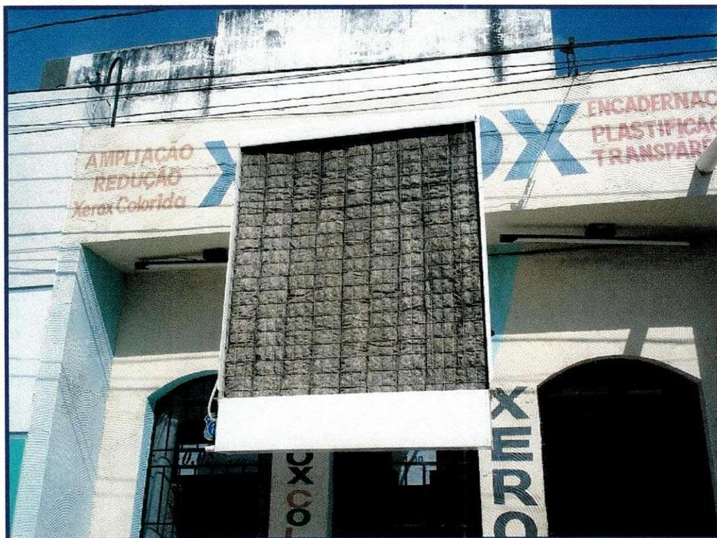
**Figura 6.16 – Painel Evaporativo Instalado em Resfriador**
