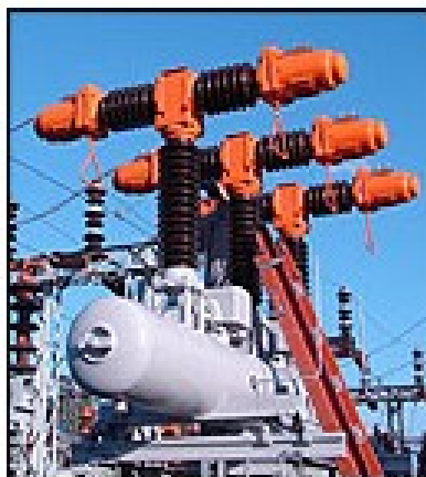
Figura 5: Disjuntor a ar comprimido de 7,2 a 245 kV (NDS engenharia, 2009).
