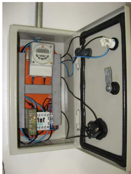
Figura 17: Foto dos equipamentos que formam o módulo de acionamento horário
