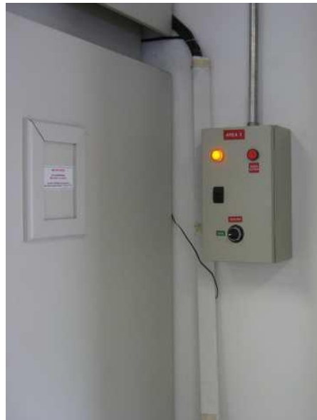
Figura 16: Foto do módulo de acionamento horário em funcionamento
