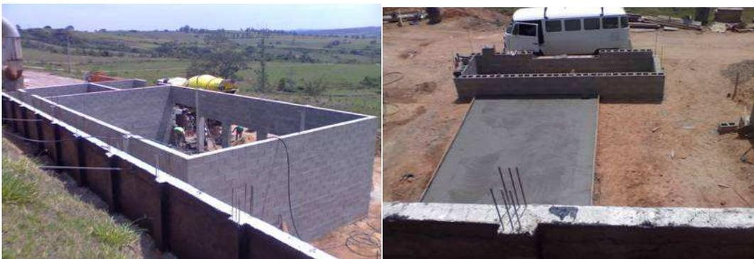
Figura 7. Obras Civas – Execução do Piso Sala e Tanque Principal.
