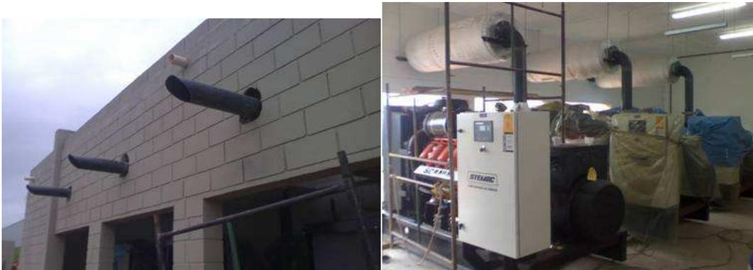
Figura 8. Instalação – Início das Etapas Diesel e Escape.
