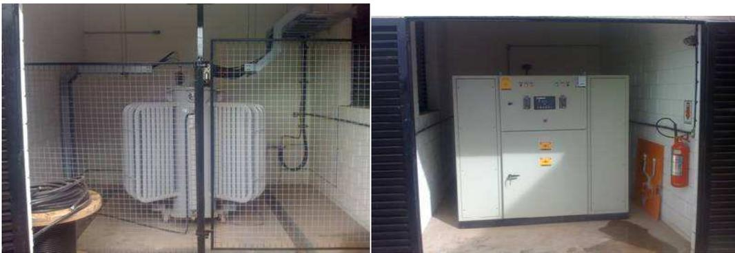
Figura 10. Instalação – PMT e Transformador.
