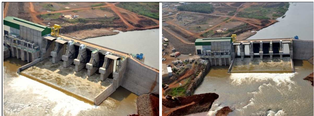
Figura 5. Vetedouro da UHE São José-RS com seis comportas (2010).
