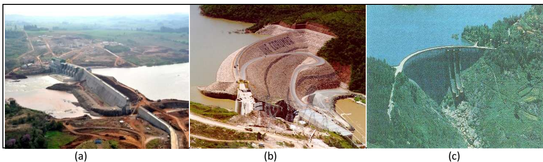
Figura 3. (a) UHE São José(2009) Barragem tipo Concreto Compactado a Rolo. (b) Barragem de Enrocamento com núcleo em argila e (c) Barragem tipo Arco-Gravidade, GE imagination at work (2006).
