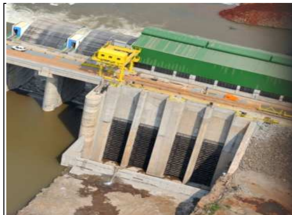
Figura 6. Grades de Proteção da Tomada d'água da UHE São José-RS (2010).
