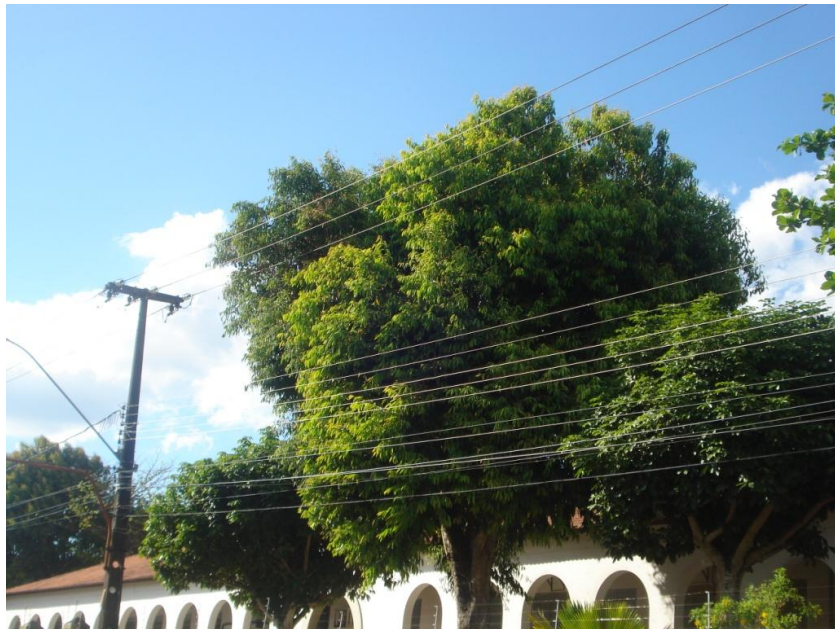
Figura 16 - Árvore nos fios de distribuição.
