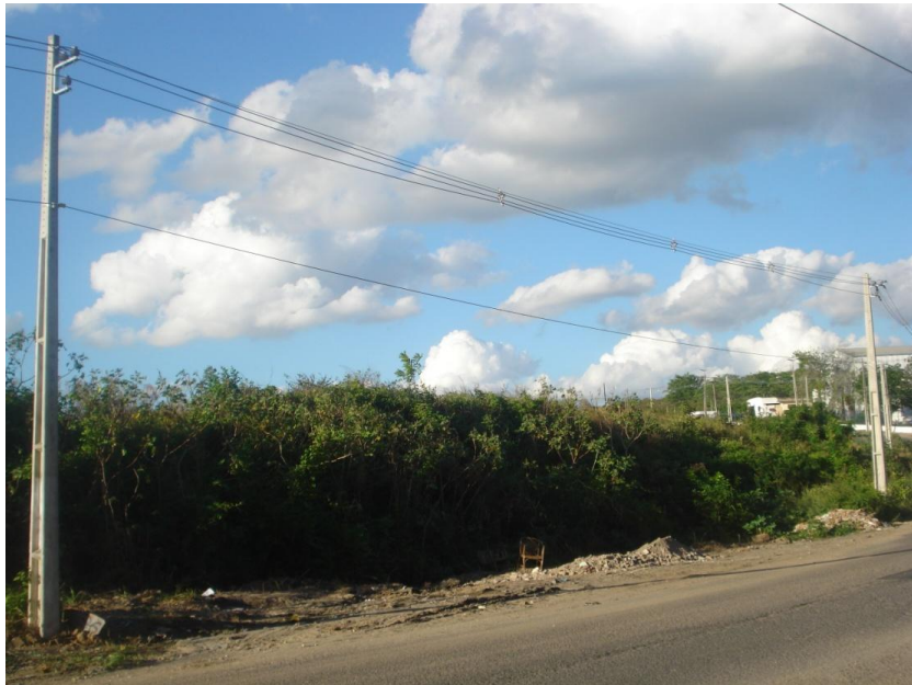
Figura 17 - Rede primária compacta – UFCG.
