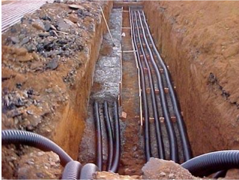
Figura 20 - Cabos subterrâneo sendo instalados.
