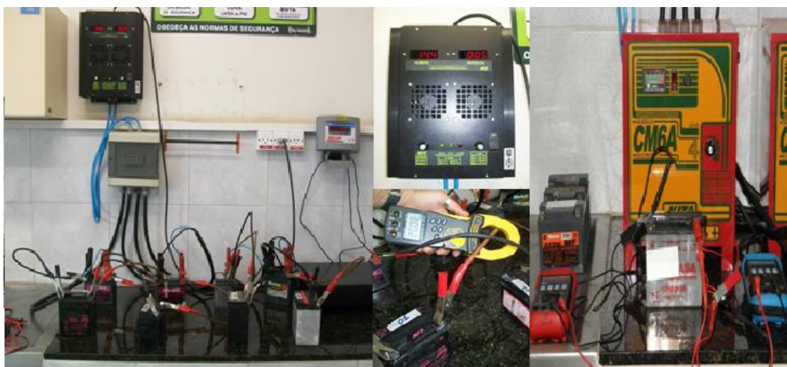
Figura 11: Estrutura de ensaios de carga de baterias
