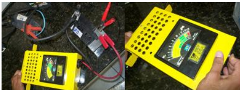
Figura 14: Teste de descarga realizado com um TB 40AM
