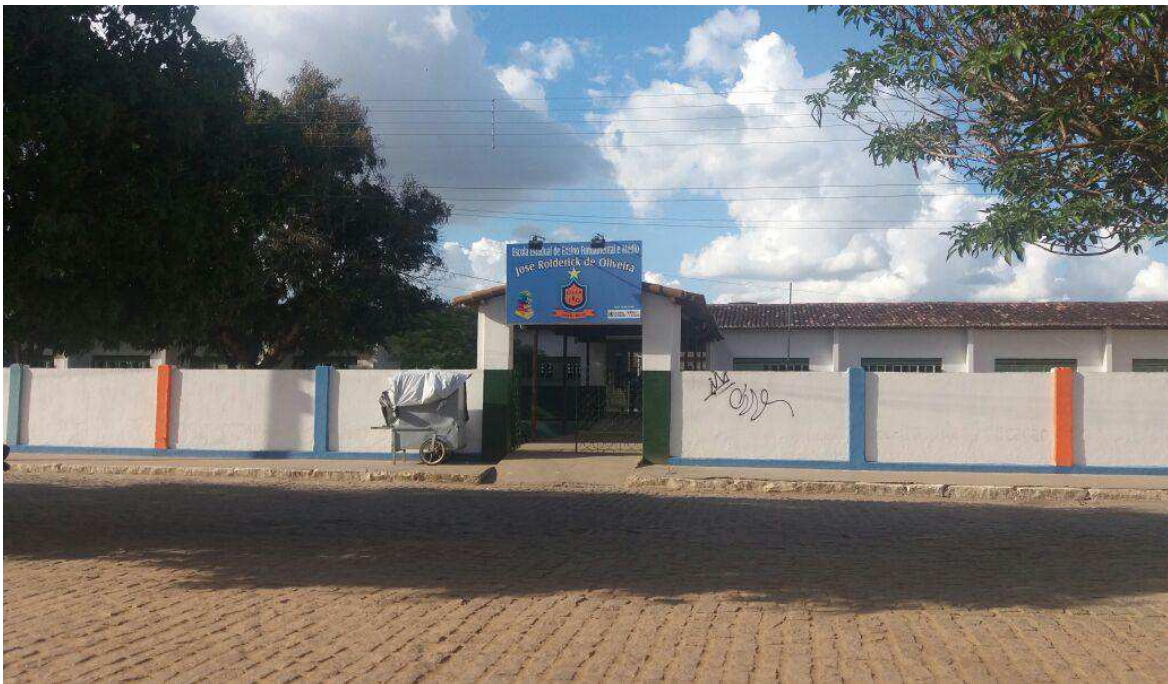
Figura 4: Fachada da Escola Municipal de Ensino Fundamental e Médio José Rolderick de Oliveira (EMEFM), Nova Floresta – PB, 2017.
