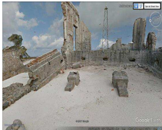
Ruínas do Antigo Farol e farolautomático.
