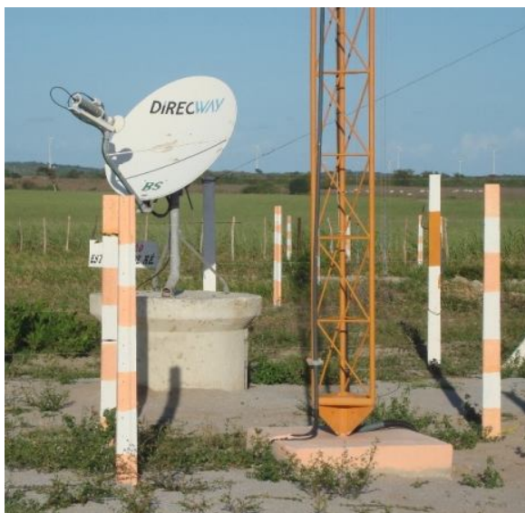
Figura 5.9 - Antena de transmissão de dados via satélite do parque Vitória.
