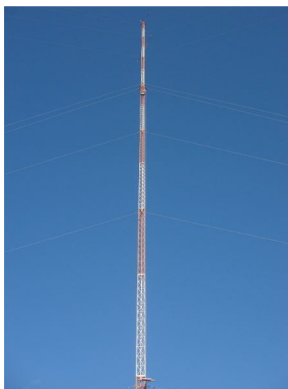
Figura 5.10 - Torre para coleta de dados dos ventos do parque Vitória.
