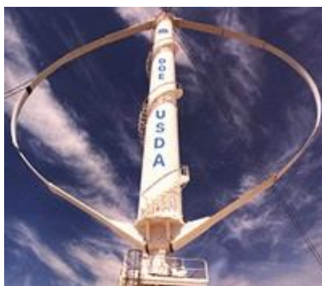
Figura 2.22 - Aeroerador experimental de eixo vertical. Fonte: Colégio São Francisco.
