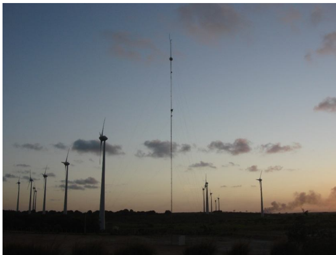
Figura 5.11 - Torre para coleta de dados eólicos do parque Vale dos Ventos.
