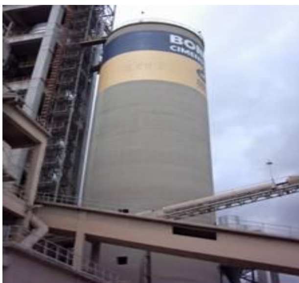
Fonte: CCB CIMPOR, 2010 Figura 2.5 – Silo de Farinha
