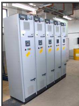
Figura 3. 15 - Conjunto Inversor de Frequência.
