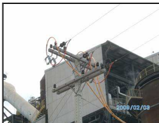
(b) Detalhe conexão cabo nu – cabo isolado.
