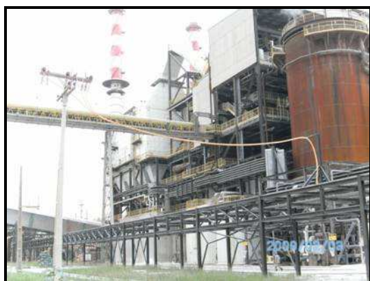
(a) Ponto de Interligação.
