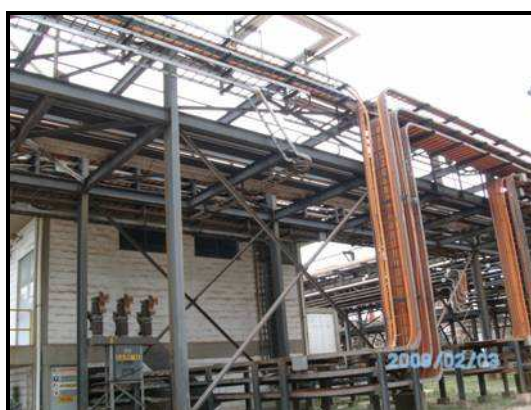
Figura 3. 2 - Detalhe encaminhamento pelo Pipe Rack .
