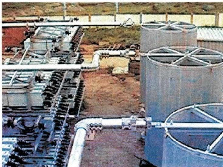
Figura 7.2 - Ligação do banco aos reatores série.
