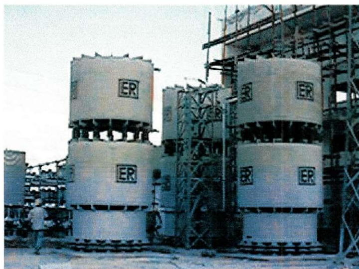
Figura 7.4 - Reatores shunt.
