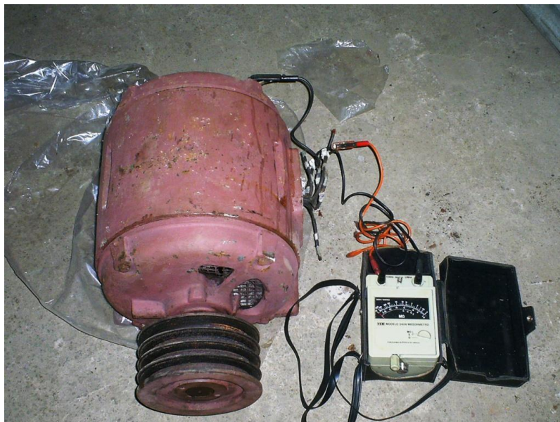
Figura 3: Conexão do Megger ao motor
