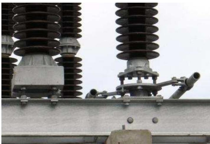
**Figura 30 - Fotografia do detalhamento da coluna rotatória.**
