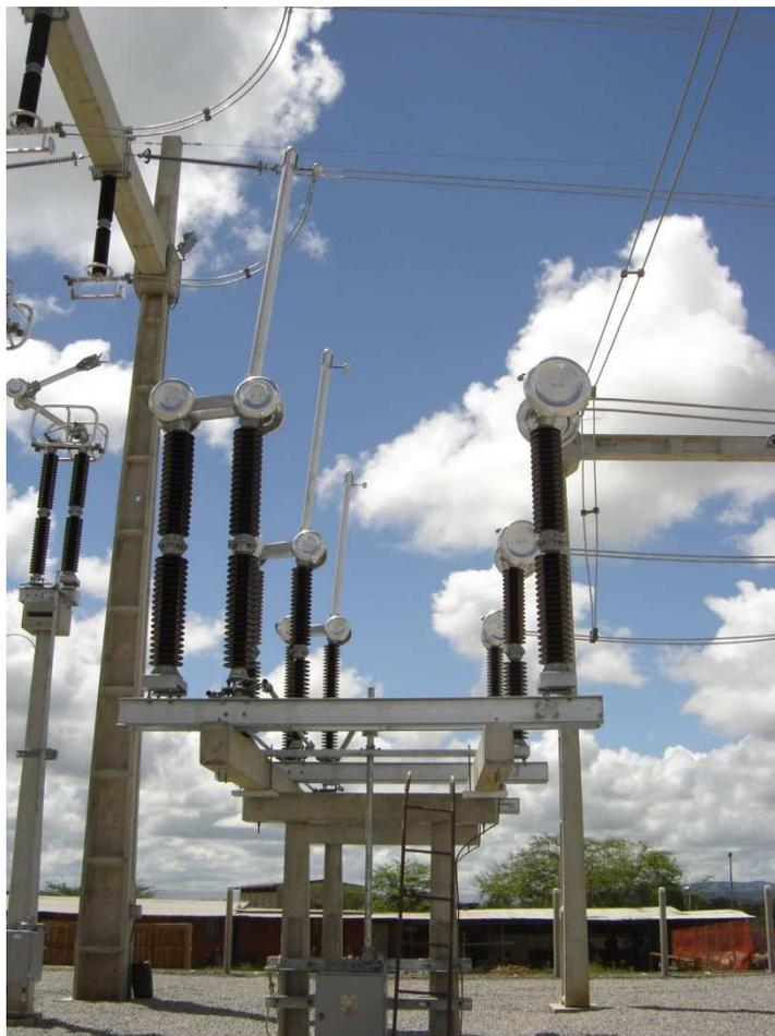
**Figura 34 - Fotografia do seccionador EVL sem LT instalado na SE CTM.**
