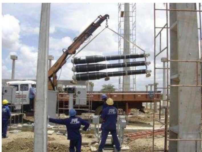
**Figura 24 – Fotografia da estrutura suporte para transporte dos pólos do disjuntor.**
