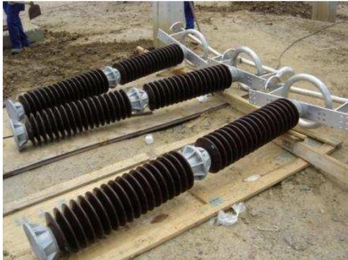
**Figura 38 - Fotografia do conjunto superior dos seccionadores semi pantográficos.**
