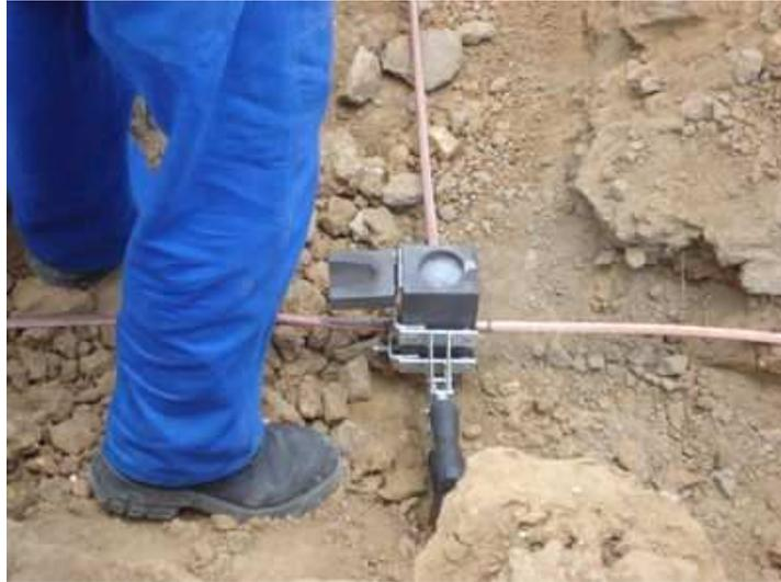
Figura 15 - Fotografia do molde em T para solda exotérmica.
