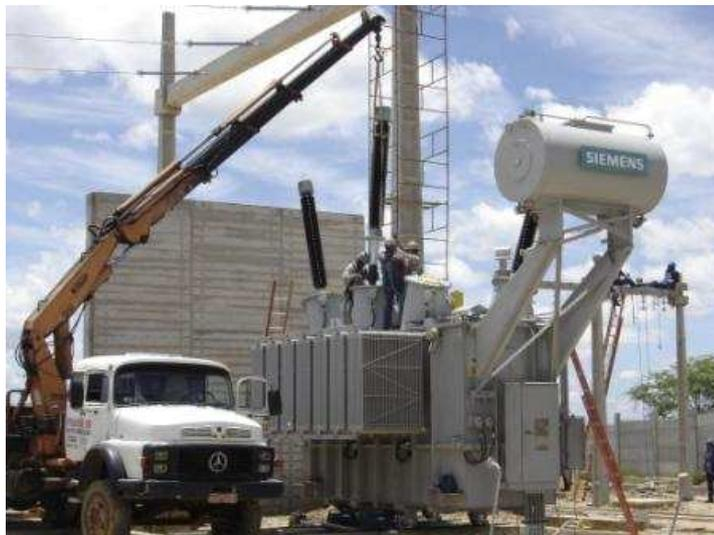
**Figura 50 - Fotografia da montagem das buchas do transformador.**
