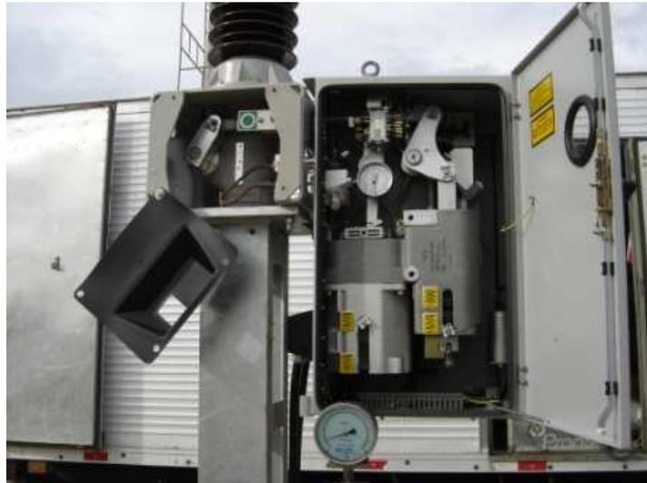
Figura 21 - Fotografia do cubículo de acionamento de um dos pólos do disjuntor.
