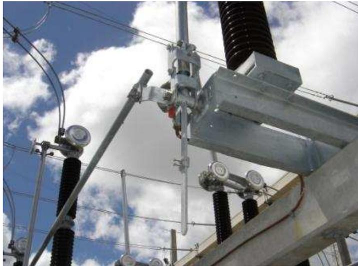
Figura 32 - Fotografia do ponto destinado à conexão da lâmina de terra.
