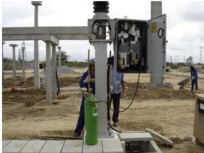
Figura 27 - Fotografia do processo de inserção de gás SF<sub>6</sub> no disjuntor.
