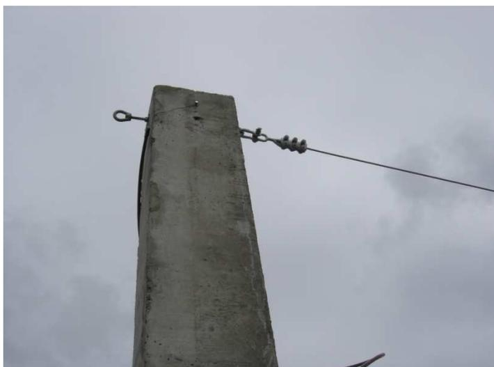
Figura 18 - Fotografia do cabo pára-raios conectado à estrutura.
