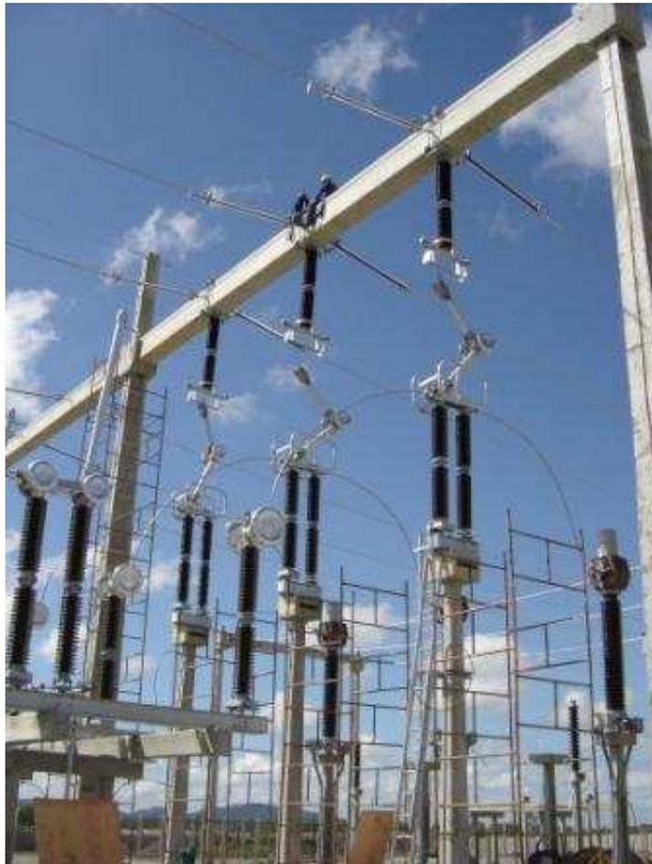
**Figura 35 - Fotografia da chave seccionadora tipo semi pantográfica instalada na SE CTM.**
