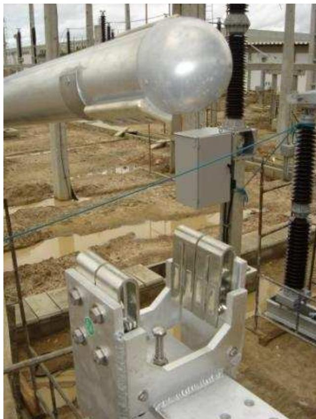
**Figura 31 - Fotografia do contato principal da chave seccionadora de abertura vertical.**
