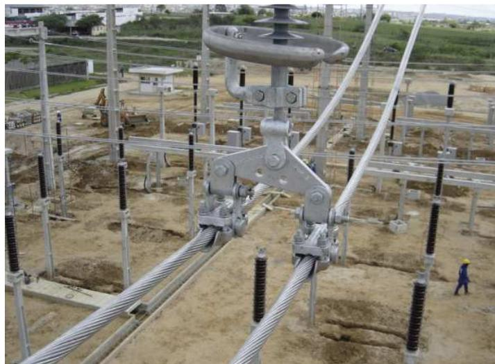
**Figura 13 – Fotografia do grampo de suspensão articulado em liga de alumínio - setor 230 kV.**
