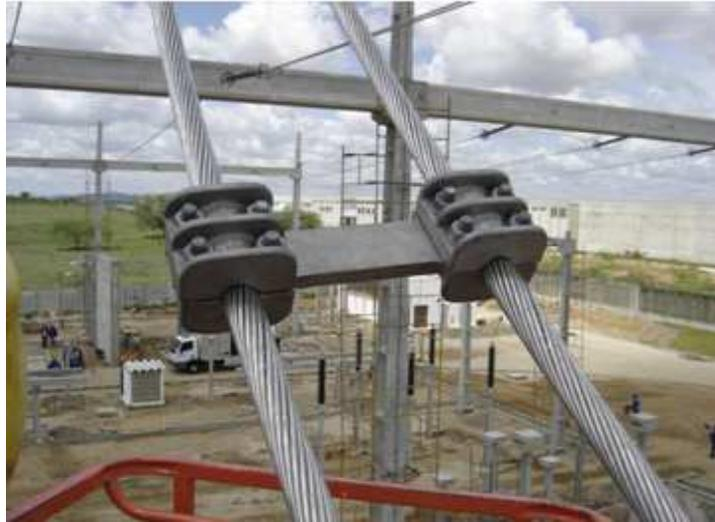
**Figura 14 – Fotografia dos espaçadores de cabos em aço forjado – setor 230 kV.**
