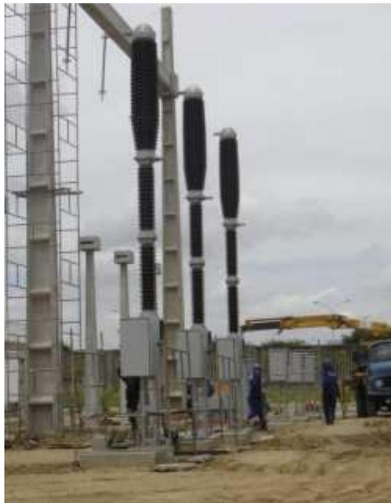
Figura 20 - Fotografia de um disjuntor de três pólos instalado na SE CTM.
