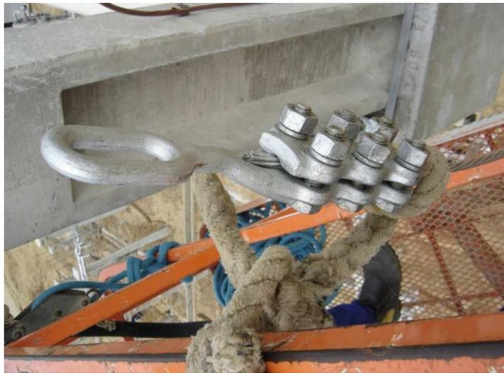
Figura 17 – Fotografia do grampo tensor para conexão do cabo à estrutura.
