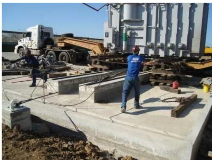
**Figura 48 - Fotografia do esquema utilizado para instalação do transformador à base.**
