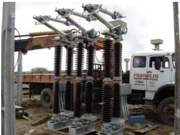
Figura 39 - Fotografia do conjunto inferior dos seccionadores semi pantográficos.
