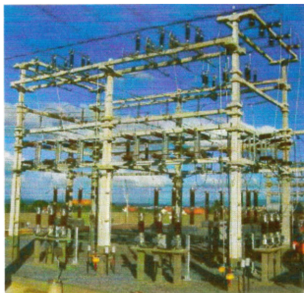
Figura 15 – Barramento 69 kV
