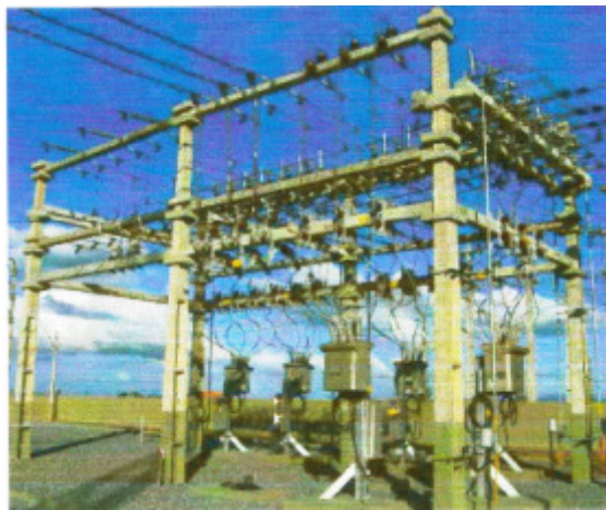
Figura 18 – Barramento 13,8 kV
