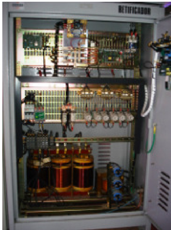
Figura 22b – Retificador (vista interna)
