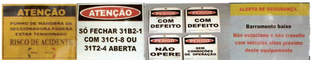
Figura 30 – Sinalização de equipamentos com limitação operacional
