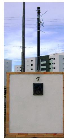
Figura 2 – Instalação em mureta
