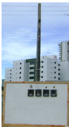
Figura 3 – Agrupamento de caixas para até 3 medições
