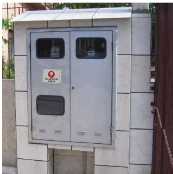
Figura 4 – Armário de medição coletiva
