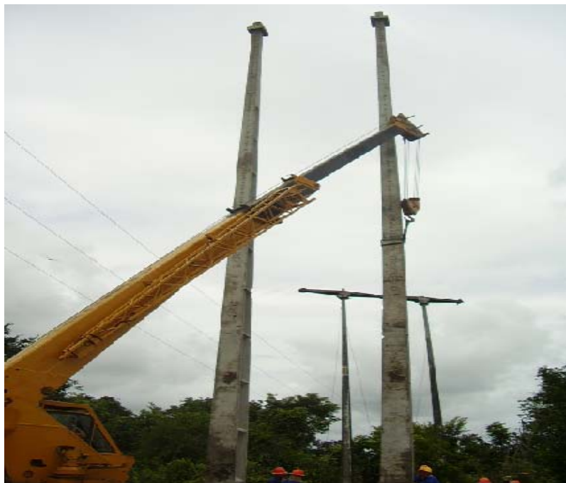
Figura 15 – Postes da Estrutura “2H” Implantados
