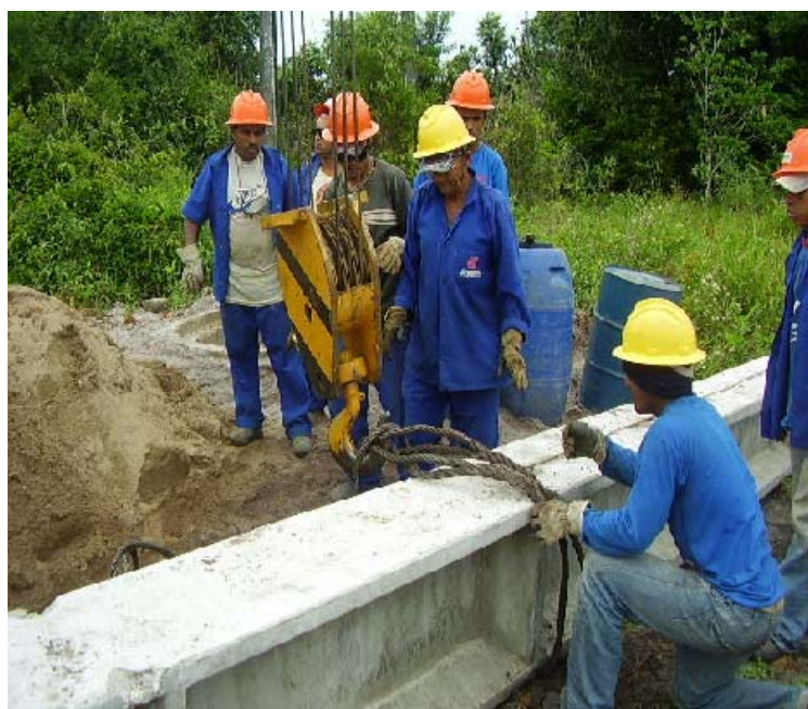
Figura 13 – Gancho do Guindaste Conectado a Alça de Aço
