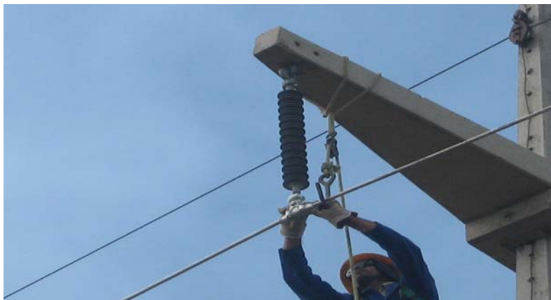
Figura 20 – Grampeação da Estrutura
