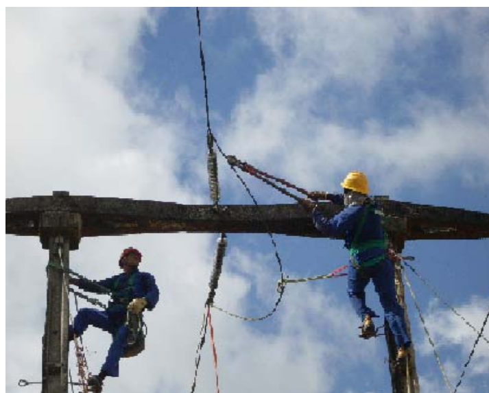
Figura 11 – Corte dos Pulos / Fase A
