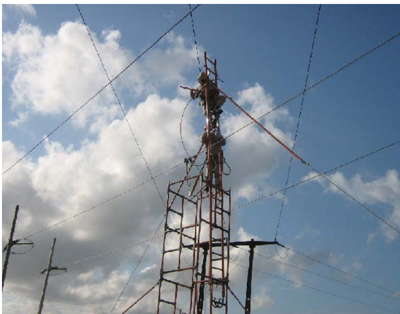
Figura 8 - Eletricitista Entrando no Potencial
