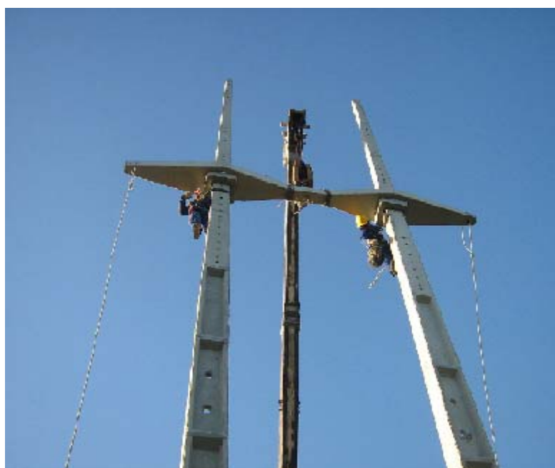
Figura 17 – Cruzeta Inferior Implantada
