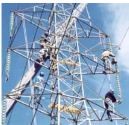
Figura 4 – Instalação dos Acessórios na Construção de Torres de Transmissão
