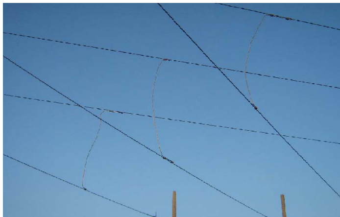
Figura 9 – Três Fases Energizadas / Conexão Linha Provisória – Linha Antiga
