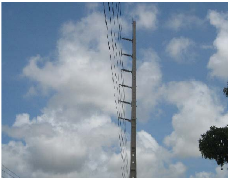
Figura 6 – Estrutura 2Y - ARP
