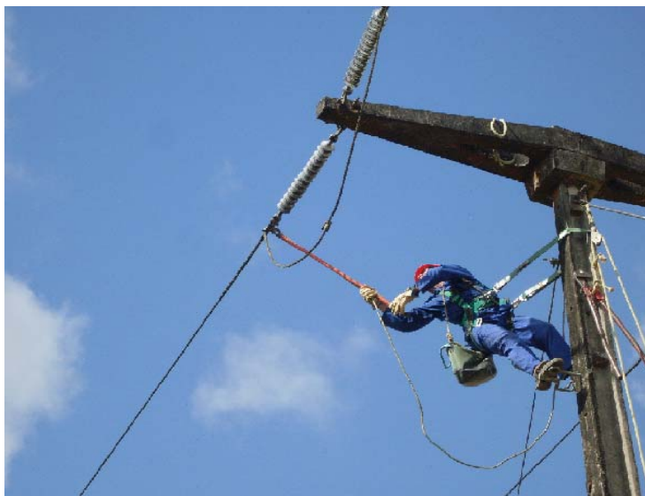
Figura 10 – Início do Aterramento na Fase B.
