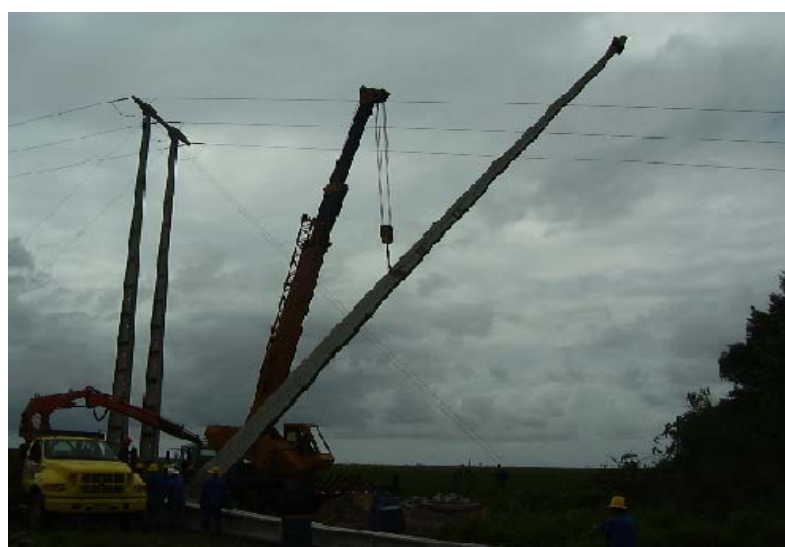
Figura 14 – Implantação do Poste
