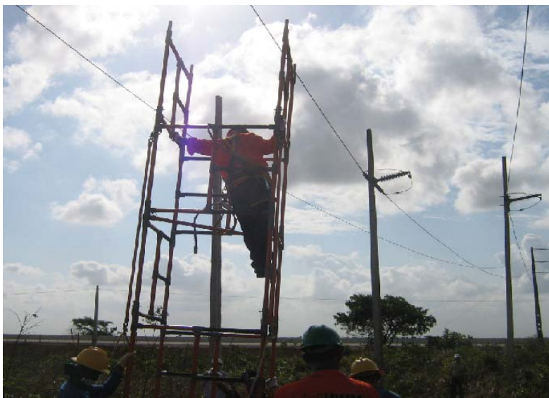
Figura 7 – Início da Montagem do Andaime Estrutura 42
