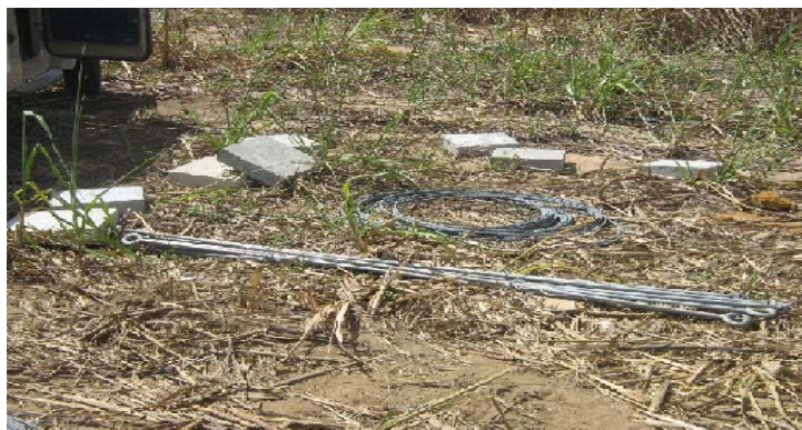
Figura 19 – Acessórios Utilizados na Implantação dos Estais
