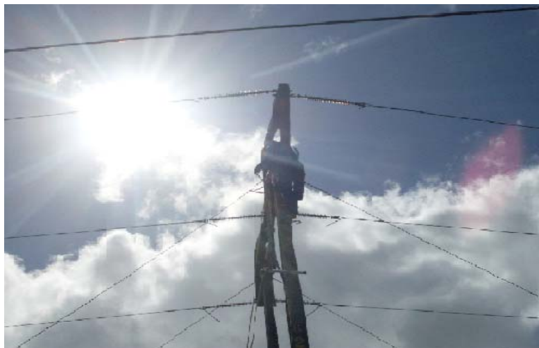
Figura 12 – Três Pulos Desconectados Estrutura 62
