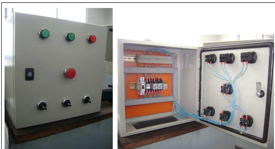
Figura 16: Painel elétrico montado para o comando automático das eletroválvulas
