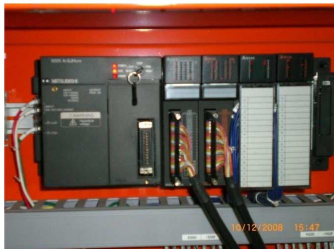
Figura 9 – CLP Mitsubishi da máquina de injetar cola.
