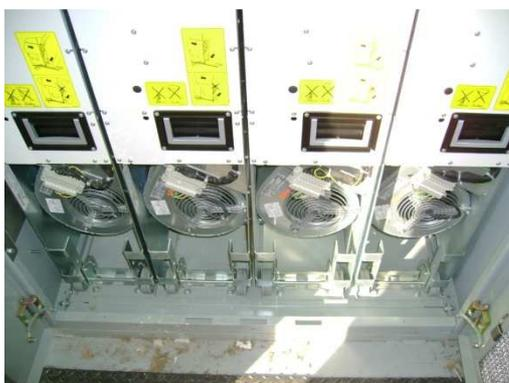
Figura 14 - Blocos de Inversores de Frequência.
