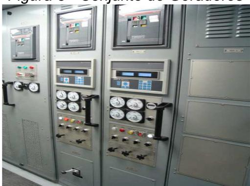
Figura 5 - Disjuntores Principais 1 e 2
