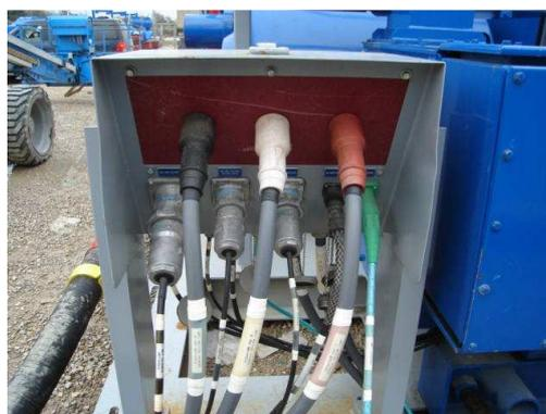
Figura 19 - Cabos de força e de comando de uma das Bombas de Lama.
