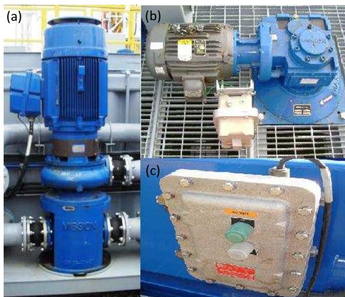
Figura 26 – a) Bomba Centrífuga c/ caixa de ligação somente, b) Agitador de Lama com caixa de conexão e caixa de comando, c) Caixa de comando em destaque.
