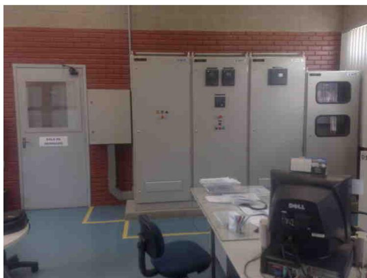
**Fig.28 – Gestal e Painéis de Controle, Proteção e Medição**
