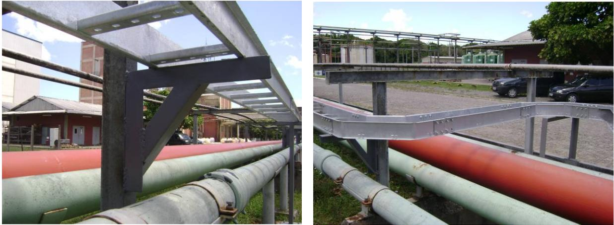
**Fig. 23 - Detalhe dos Leitos para os Cabos de Média Tensão**
