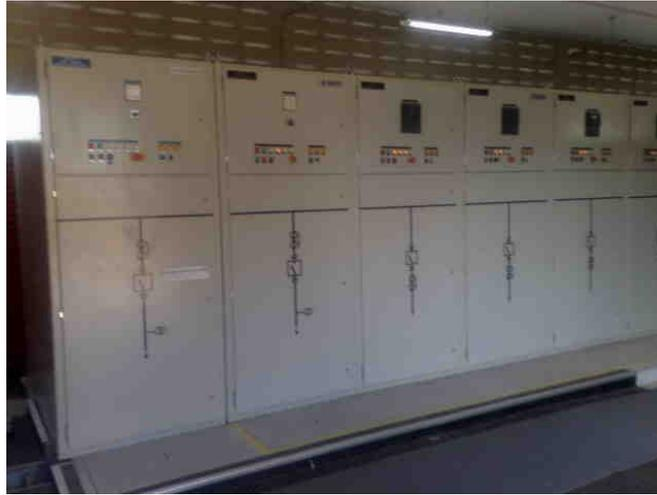
**Fig. 25 – Painéis de Média Tensão (PNMT- C1 à esquerda)**
