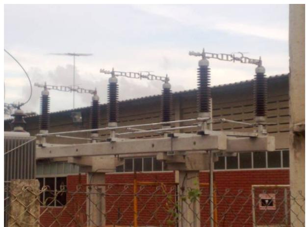
**Fig. 22 - Chave Seccionadoras Tripolar: Antiga e Nova**
