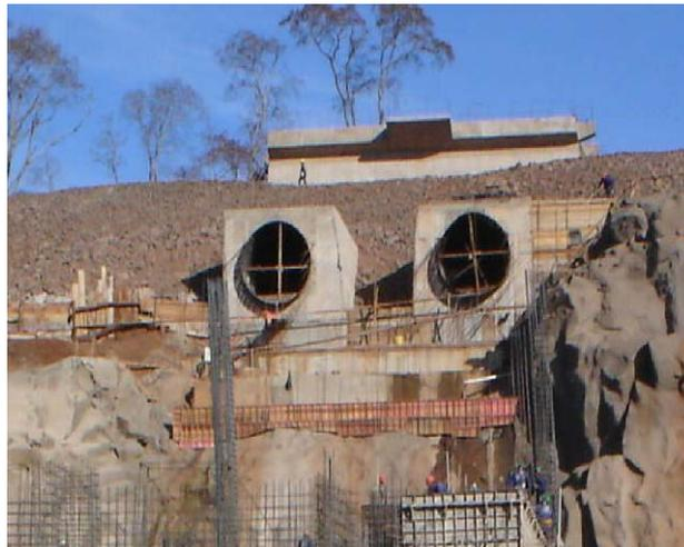
**Fig. 10 – PCH em construção – Condutos forçados seccionados que serão acoplados nas máquinas hidráulicas da casa de força.**
