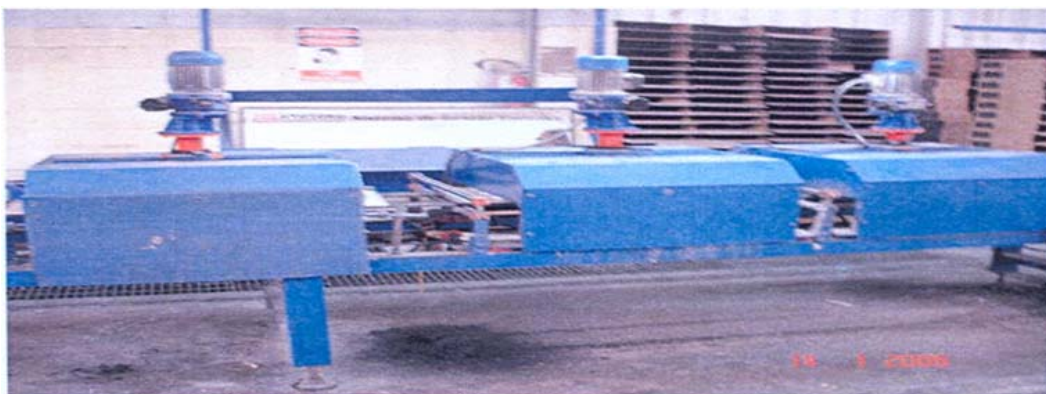
Figura 6.13 - Escovas para espalhar o impermeabilizante
