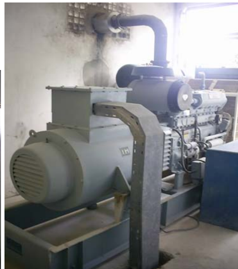
Figura 4.4 - Geradores de 450 kVA
