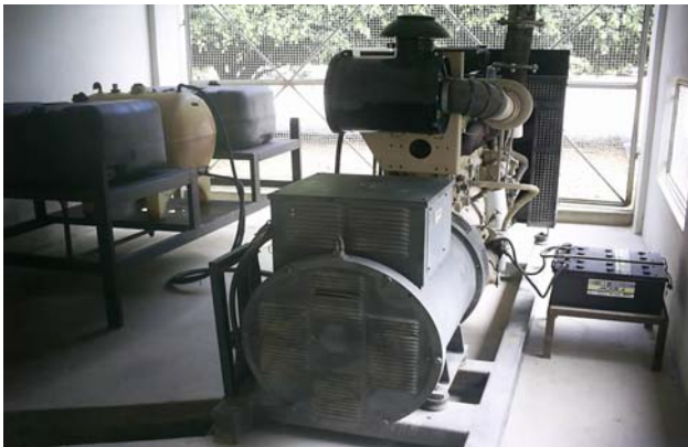
Figura 4.4 - Geradores de 450 kVA
