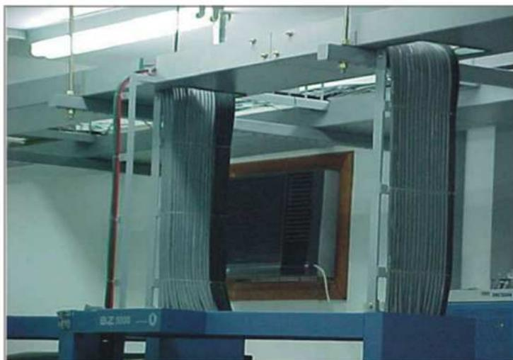
Figura 05: Esteiramento vertical dos cabos de assinantes
