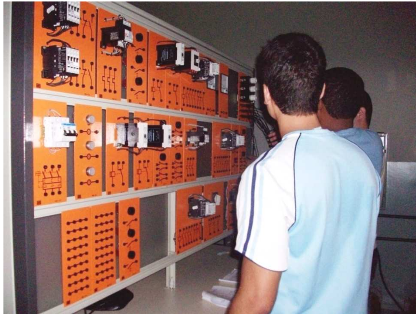
Figura 3.8 – Alunos realizando experimento do Lab. de Instalações Elétricas.
