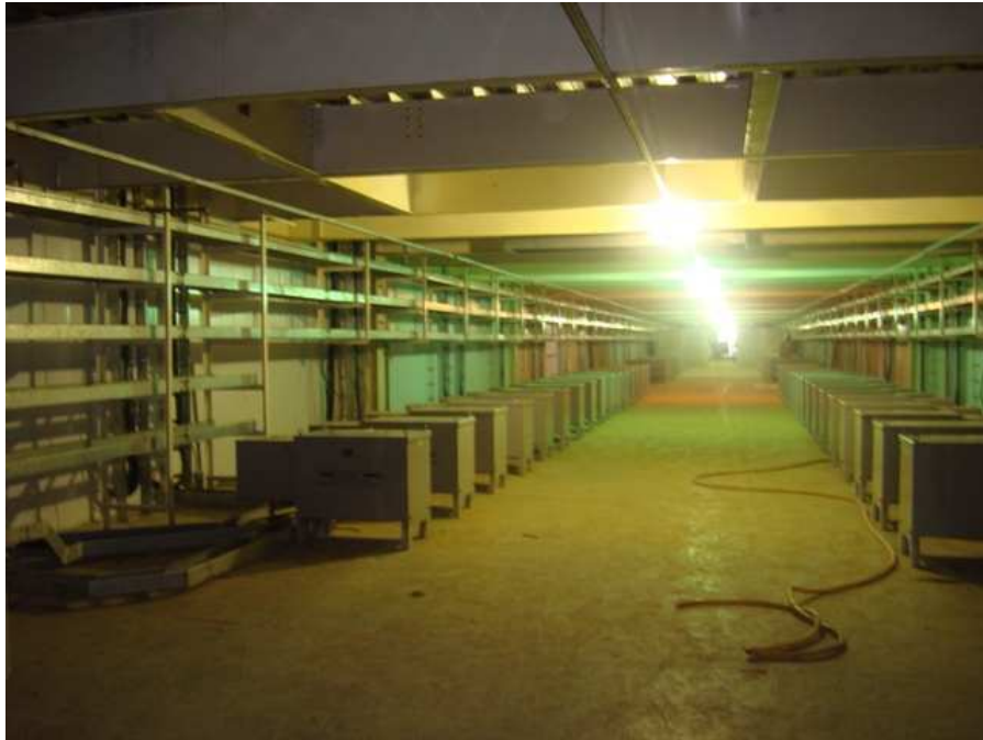
Figura 2.2 – Resistores instalados.
