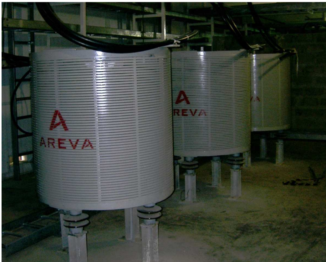
Figura 2.4 – Reatores instalados.
