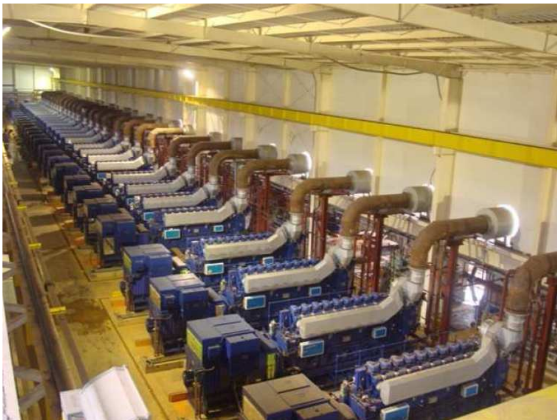
Figura 2.1 – Geradores de 2,5 MW da Hyundai Motores .
