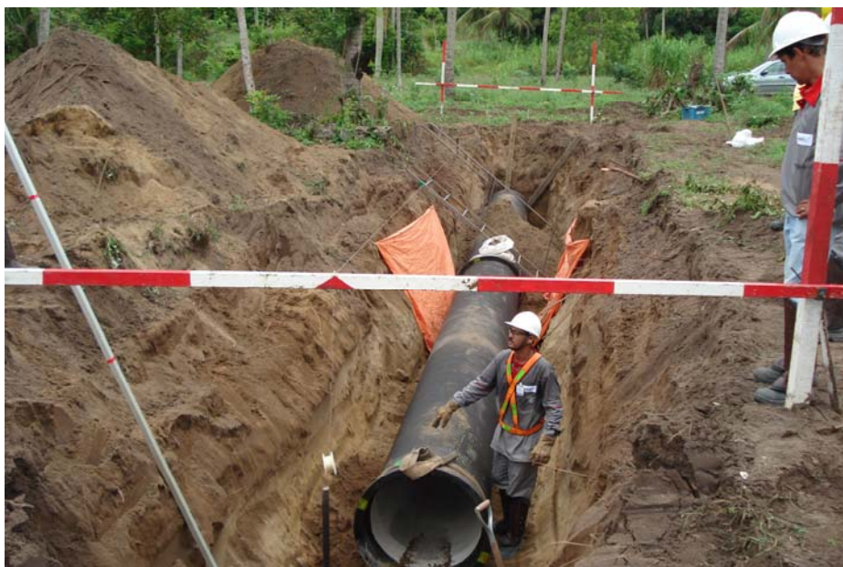
Figura 7 – Assentamento de trechos da adutora
