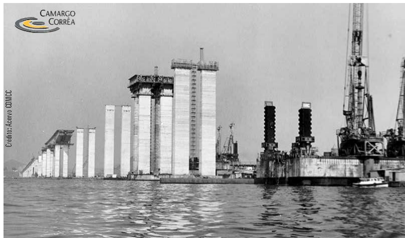
Figura 1 – Ponte Rio Niterói, RJ, anos 1970
