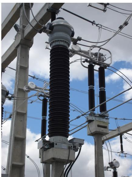
**Figura 10 - TC fabricado pela TRENCH Itália.**
