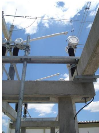
Figura 26 - Fechamento da seccionadora.
