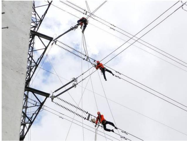
**Figura 33 - Trabalho de seccionamento da linha 04C3.**
