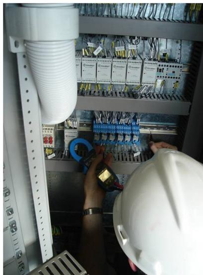
Figura 22 - Verificação do potencial em um determinado ponto do circuito.
