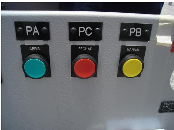
Figura 25 - Botões do painel da seccionadora.
