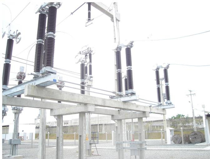
**Figura 13 - Seccionadora de abertura vertical sem lâmina de terra.**
