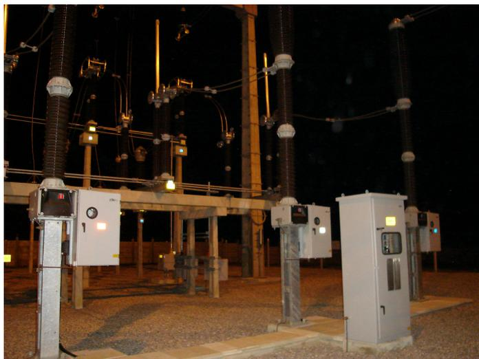
**Figura 32 - Disjuntor a SF<sub>6</sub> do vão B.**
