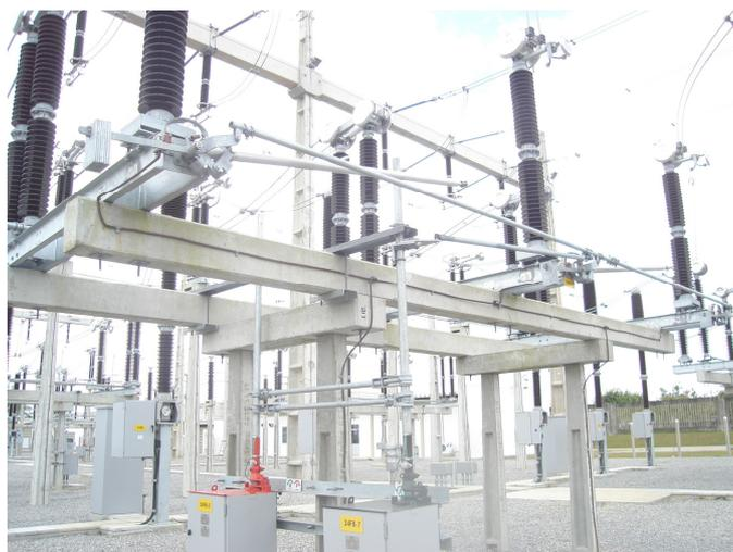
**Figura 14 - Seccionadora de abertura vertical com lâmina de terra.**
