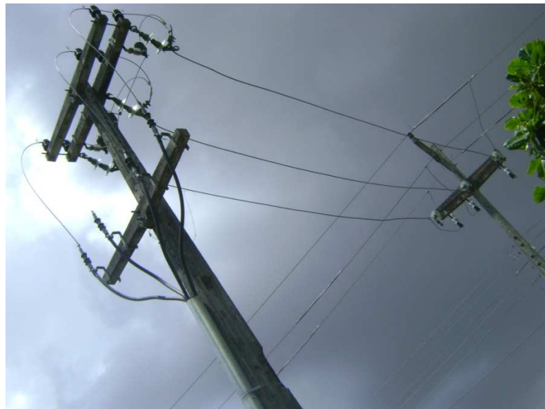
Figura 2.01 – Ramal de Ligação do Campus Campina Grande da UFCG.
