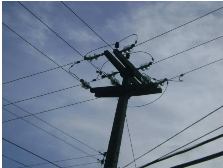
Figura 2.02 – Rede de Média Tensão Convencional.
