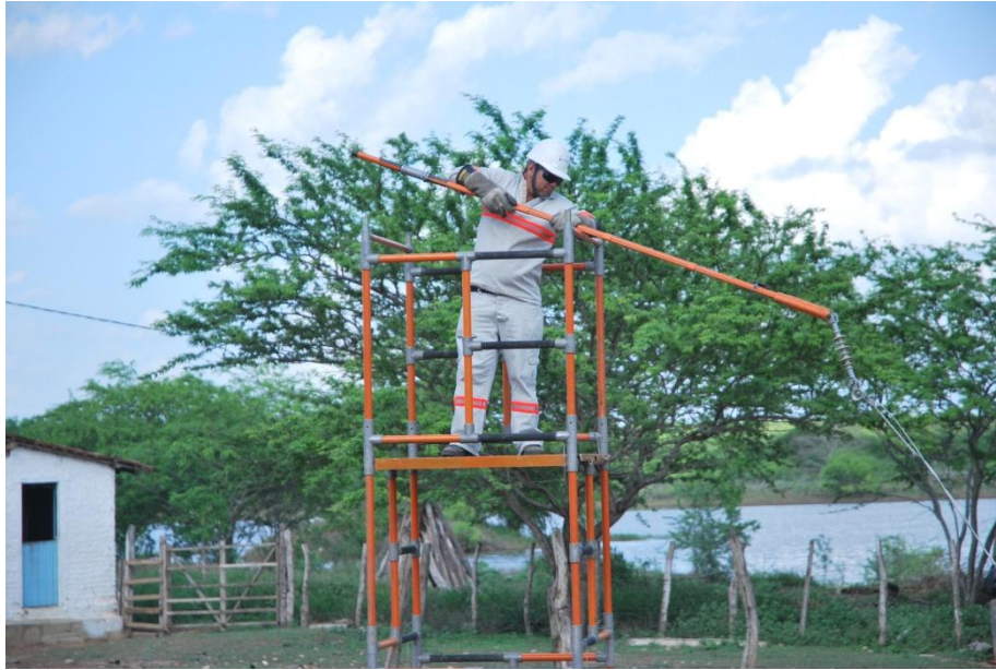
Figura 27: Eletricista de linha viva manobrando o condutor
