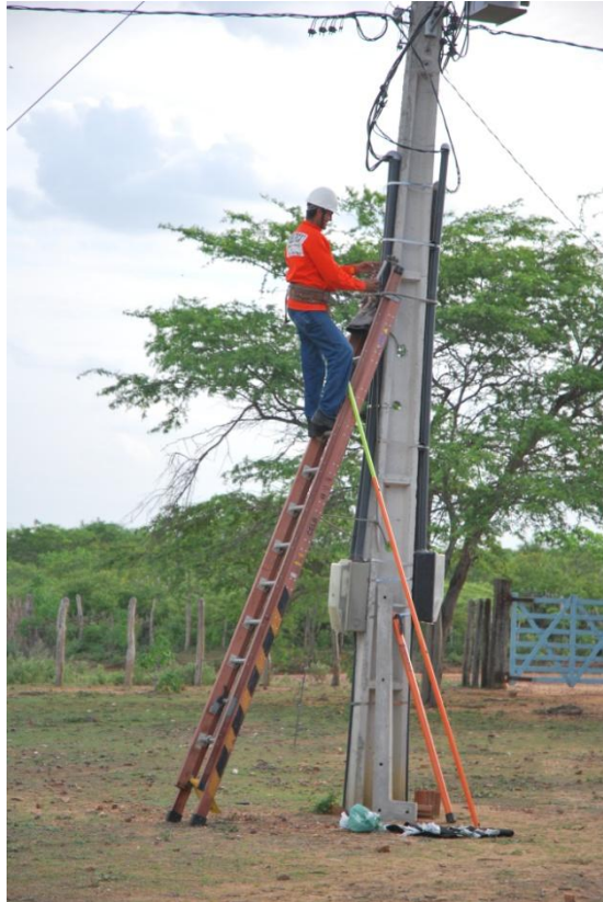
Figura 28: Técnico fazendo troca de elo fusível
