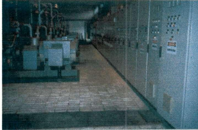
Figura 1. Foto da casa de máquinas
