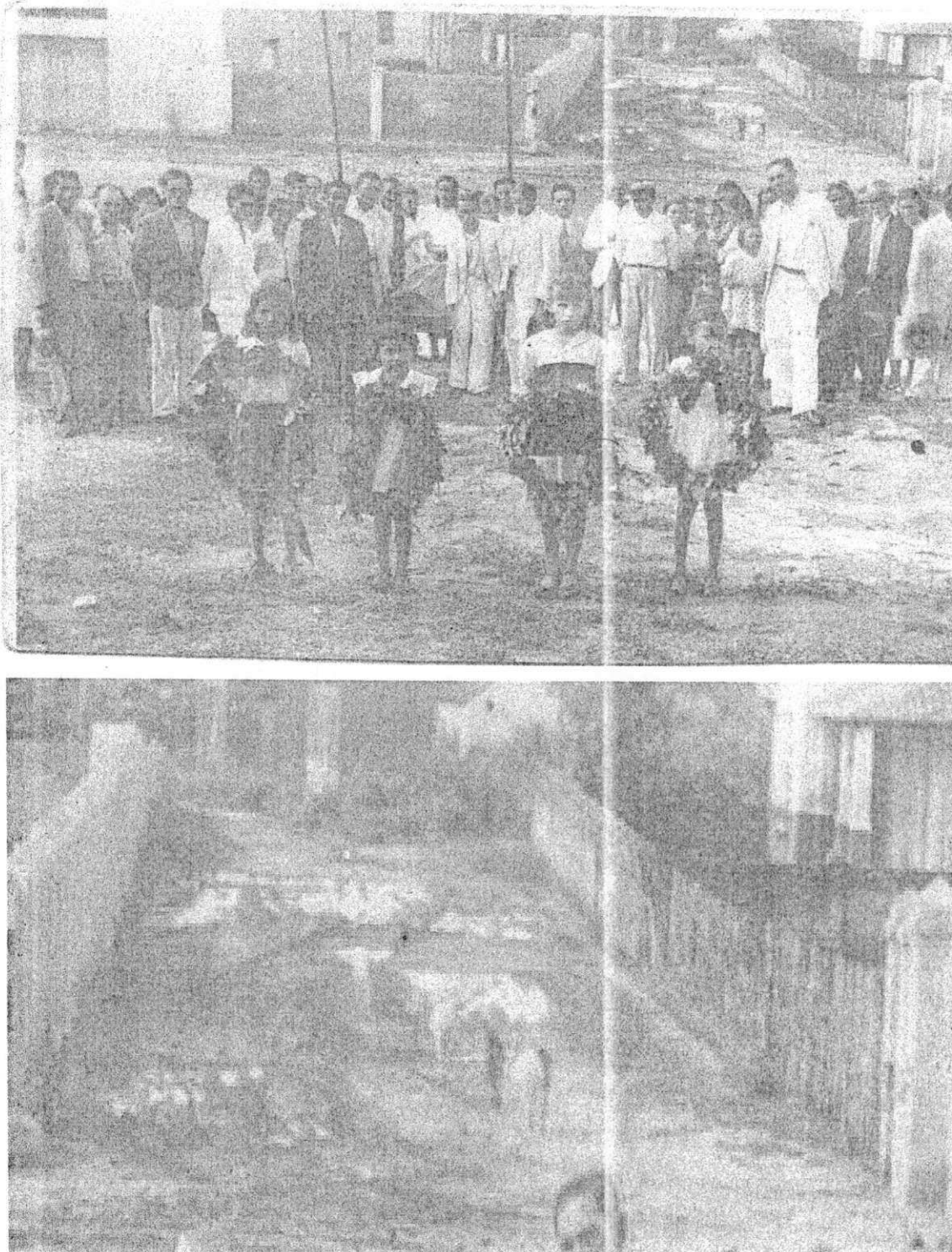
FOTO 5: A imagem acima se refere ao enterro da senhora Vitalina Gouveia, fins do ano de 1936. O detalhe ao fundo da fotografia foca a ruas cheia de lama, animais soltos nela, casas com muito mato em volta e com suas cercas de estacas e arame em volta, e não paredes servindo de muro.
