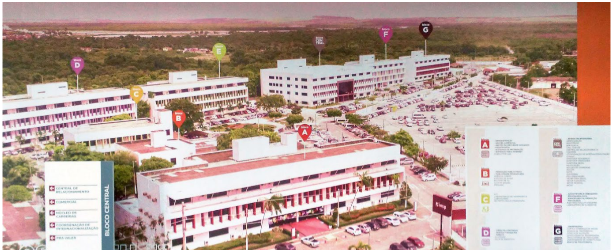
Figura 29 - Vista aérea de todos os blocos da instituição.
