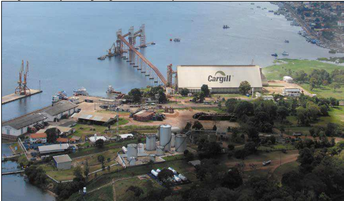
Fotografia 4 - Empresa Cargill Agrícola S/A. Instalações do Terminal Fluvial de Granéis em Santarém (PA).
