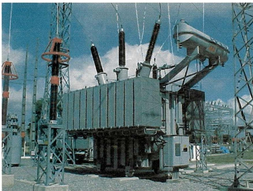
Figura 9 – Transformador trifásico 230/138/69kV.
