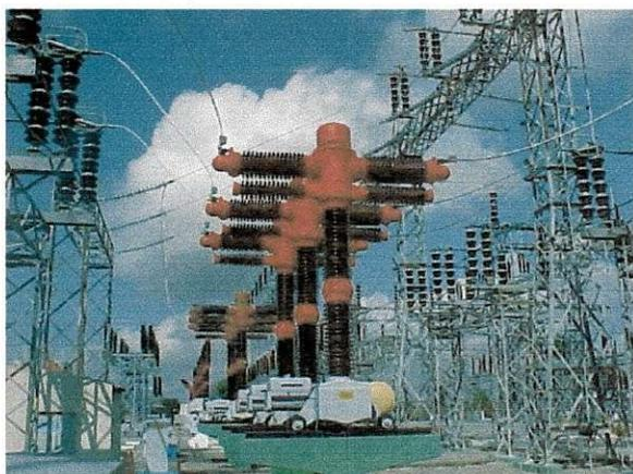
Figura 7 – Disjuntor SIEMENS 230kV.
