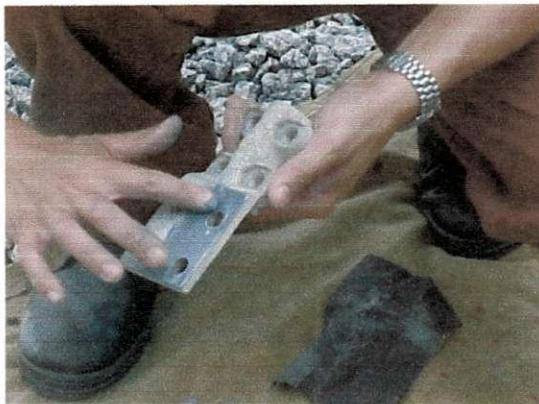
Figura 18– Correção de ponto quente no conector móvel.
