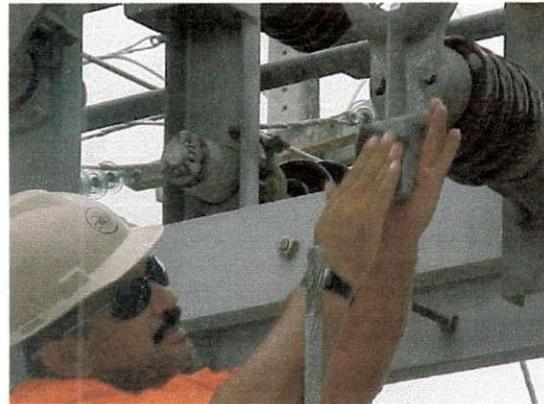
Figura 19 – Correção de ponto quente no conector fixo.
