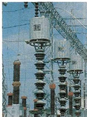
Figura 6 – Bobinas de bloqueio.
