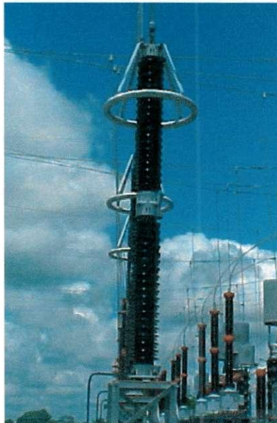
Fig. 06 (Para-Raio 230KV)
