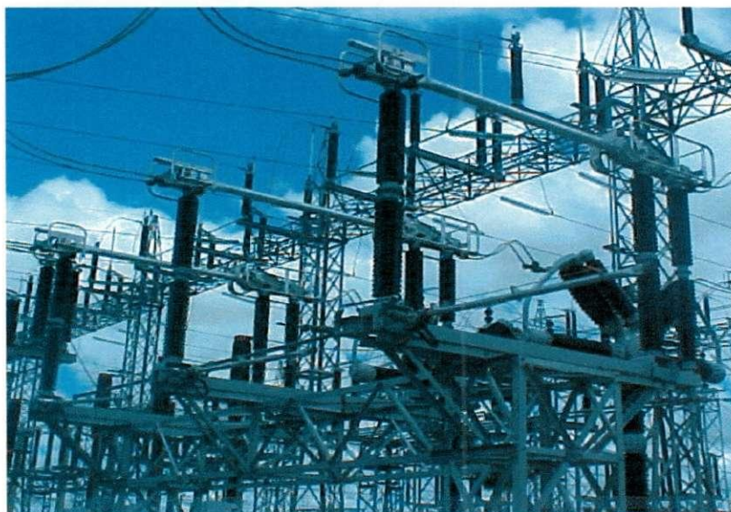
Fig. 14 (Chave Seccionadora)
