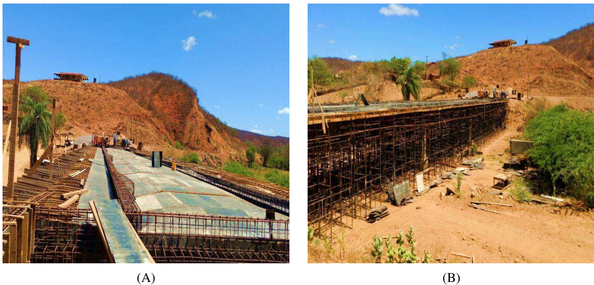
Figura 14 - Construção da ponte sobre o riacho Santa Inês-PB.
