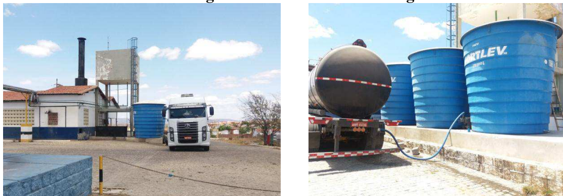
Figura 23- Abastecimento de água.
