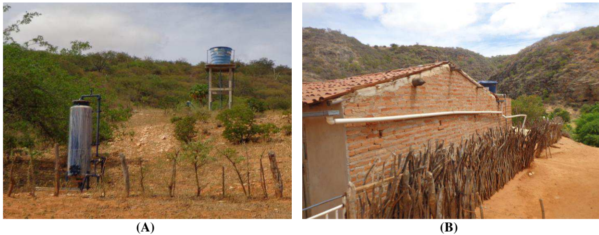
Figura 46 - Abastecimento de água no povoado de Angicão por poço artesiano (A) e cisternas (B).
