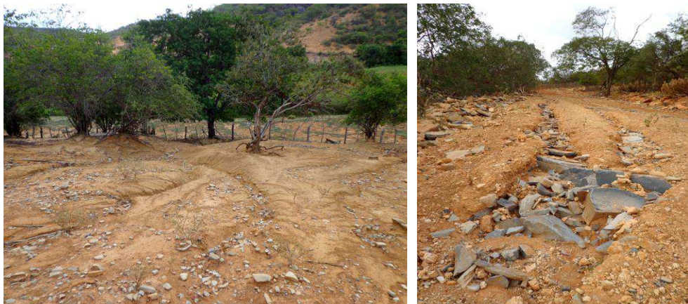
Figura 20 - Erosões na área de estudo próximo à comunidade dos Brejões.
