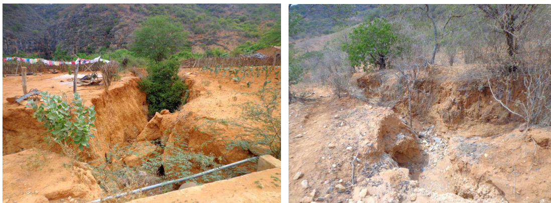
Figura 21 - Erosão por voçorocas no povoado de Angicão
