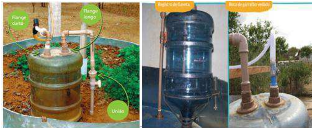
Figura 24. Sistema de filtragem física do biogás proposta
