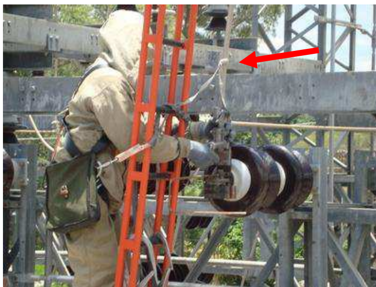
Figura 7 - Fotografia da equalização da roupa condutiva utilizando a cordoalha da roupa.
