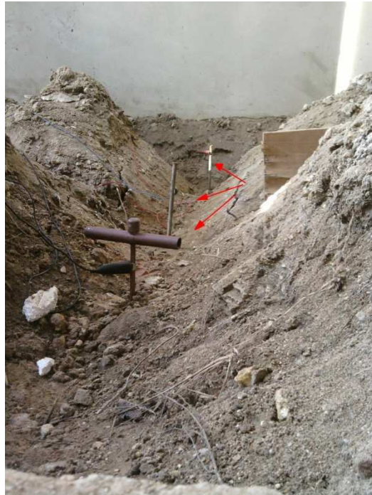
Figura 6.8 – Disposição das hastes, 2 já fincadas e 1 do kit de medição
